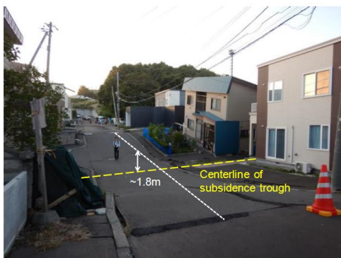
(a) 盛土造成部の沈下状況
