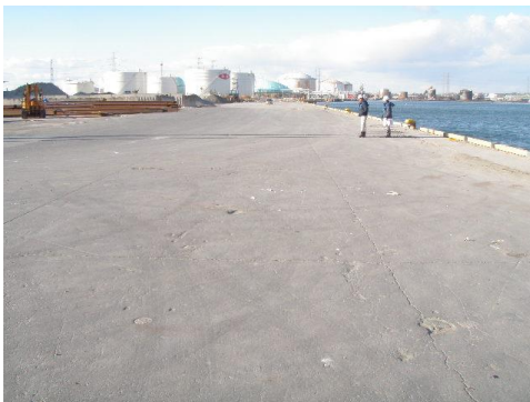
(a) 仙台塩釜港高松ふ頭岸壁
