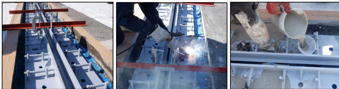
(1) 伸縮装置の設置
