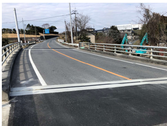
写真－7.11 工事完成
