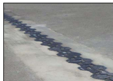
(6) 伸縮装置設置完了
