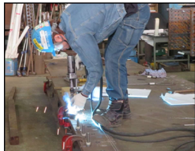
(1) 鋼板パラペットに ジベル筋を溶接
