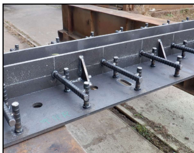
(4) 鋼板パラペットに 補剛材溶接
