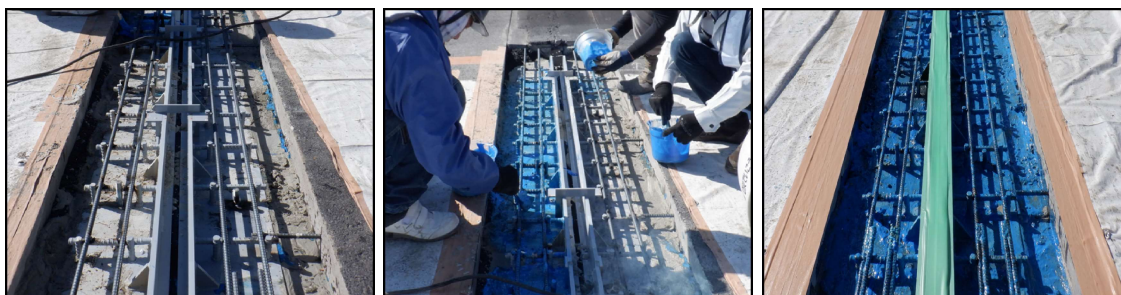
(1) 流動性モルタル充填完了 (2) 鋼材に付着用接着剤塗布 (3) 鋼材に付着用接着剤塗布完了
