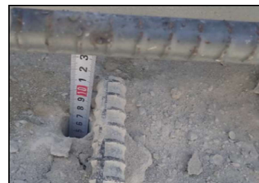
(3) アンカー孔深さ確認
