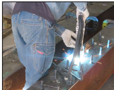
(2) 荷重分布鋼板に縦筋 を溶接
