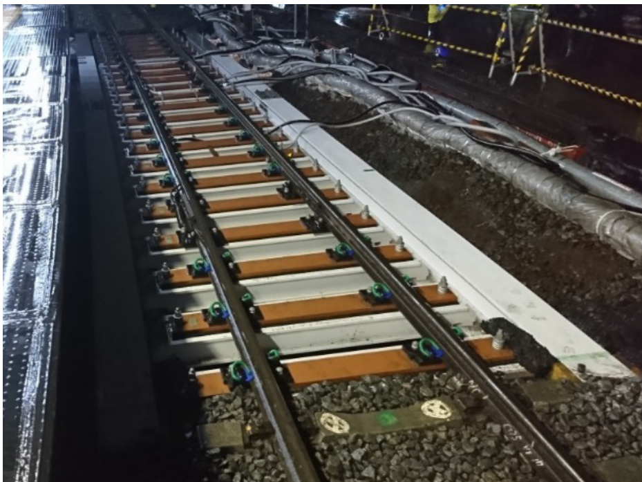
図 4-4 工事桁の敷設状況
