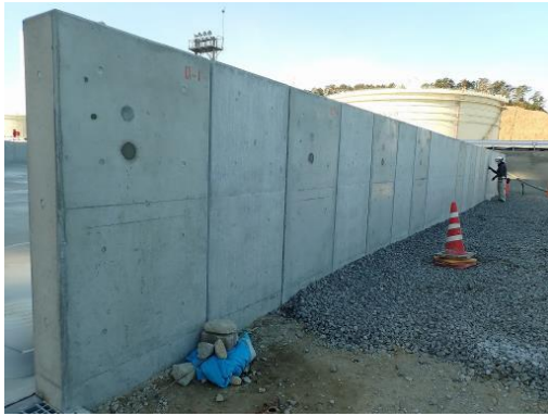
写真 3.14 コア採取した屋外暴露試験体
