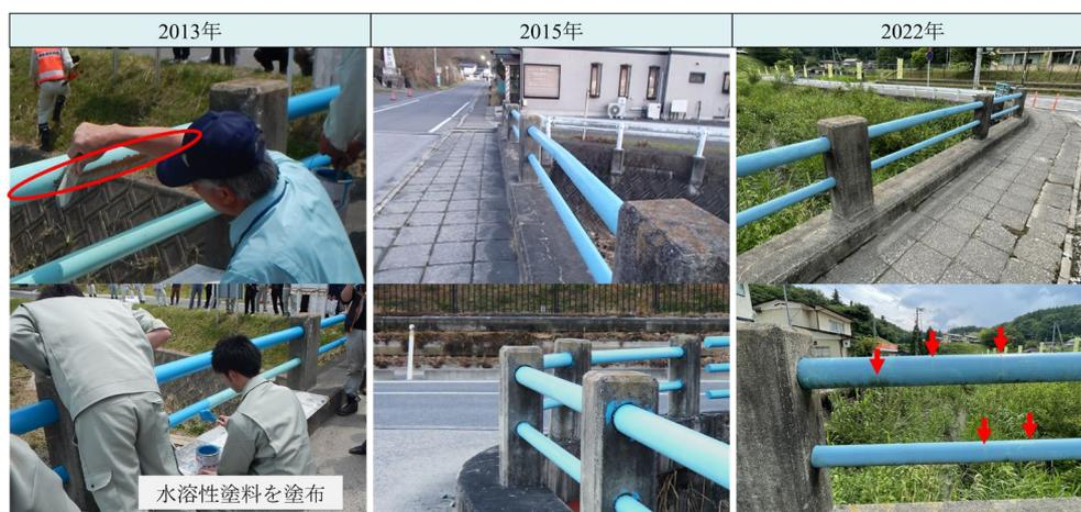
図-5.6.6 逆水橋の高欄塗装後の経過
