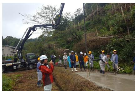
(c) コンクリートポンプ車により打設
