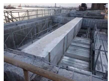
写真－8.6 完成状況
