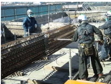
写真－8.4 設置状況
