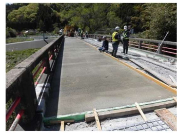
(5) コンクリート打設完了
