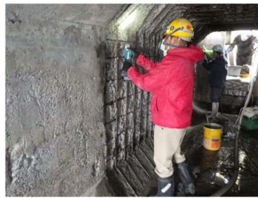
(2)鉄筋のケレン
