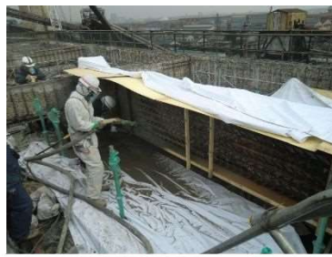
写真－8.5 吹付状況
