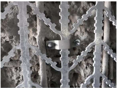
(7)固定金具設置完了
