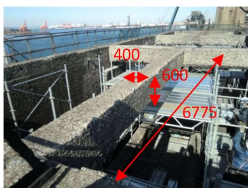
写真-8.1 既設 RC はり
