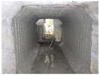
(4)防錆ペースト塗布完了
