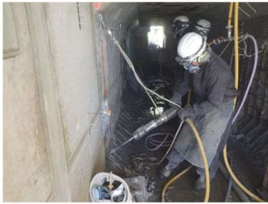
(1)劣化部のはつり
