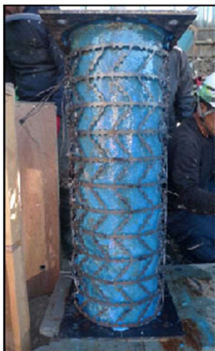
(4)メタルグリッド筋設置
