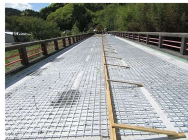
(2) メタルグリッド筋設置
