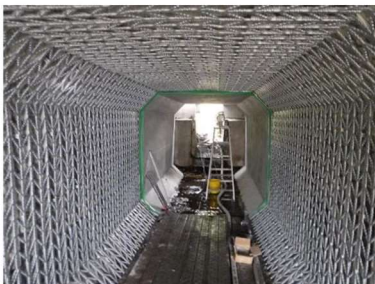
(8)メタルグリッド筋設置完了
