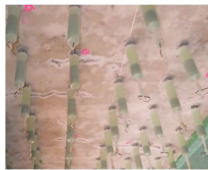
(2) ひび割れ補修
