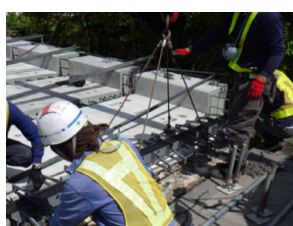
(1)伸縮装置設置 (2)接着剤注入孔削孔 (3)浸透性接着剤注入 (4)浸透性接着剤塗布
