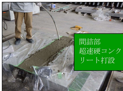
(3)コンクリート打ち込み
