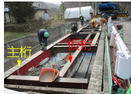
(4)スタッドジベル筋の取付け
