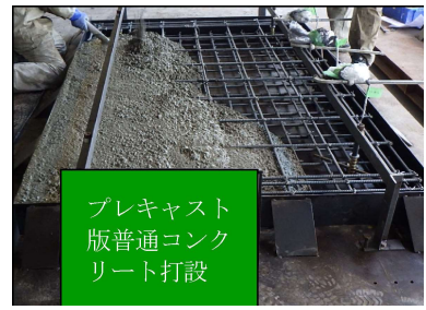
(3)コンクリート打設
