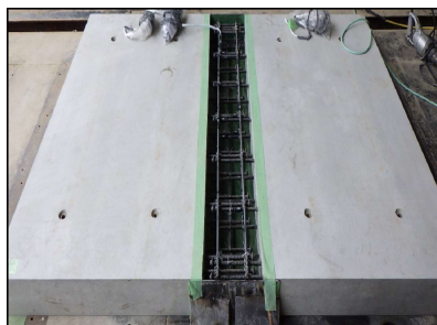
(1)プレキャスト床版設置
