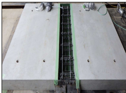
(1)プレキャスト床版設置
