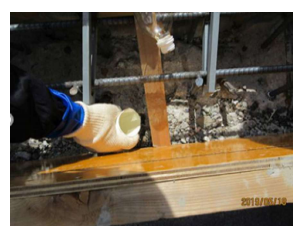
(1)伸縮装置設置 (2)接着剤注入孔削孔 (3)浸透性接着剤注入 (4)浸透性接着剤塗布
