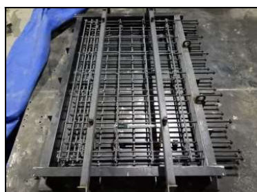
(1)鉄筋を型枠に設置
