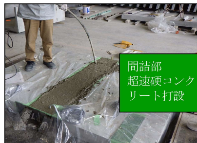
(5)コンクリート打ち込み
