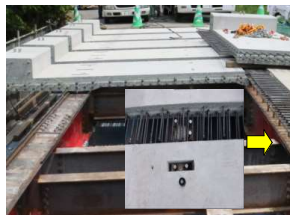
(2)間詰部の鉄筋配置
