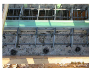
(1)伸縮装置設置 (2)接着剤注入孔削孔 (3)浸透性接着剤注入 (4)浸透性接着剤塗布
