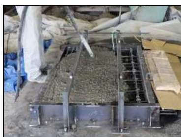
(2)コンクリート打ち込み
