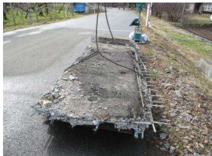
(3)撤去後の床版
