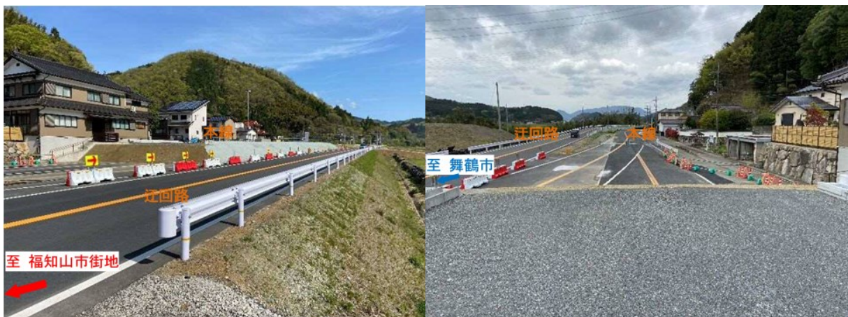
図 5-3 道路嵩上げ政策の導入例 3 (日本・国道 175 号線)
