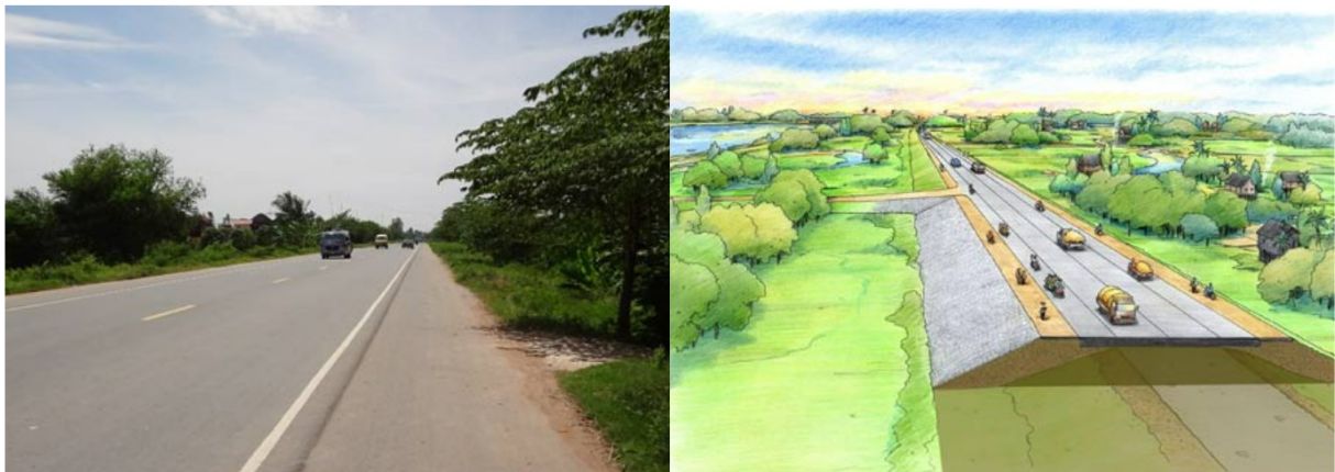
図 5-2 道路嵩上げ政策の導入例 2 (カンボジア王国・国道 1 号線)
