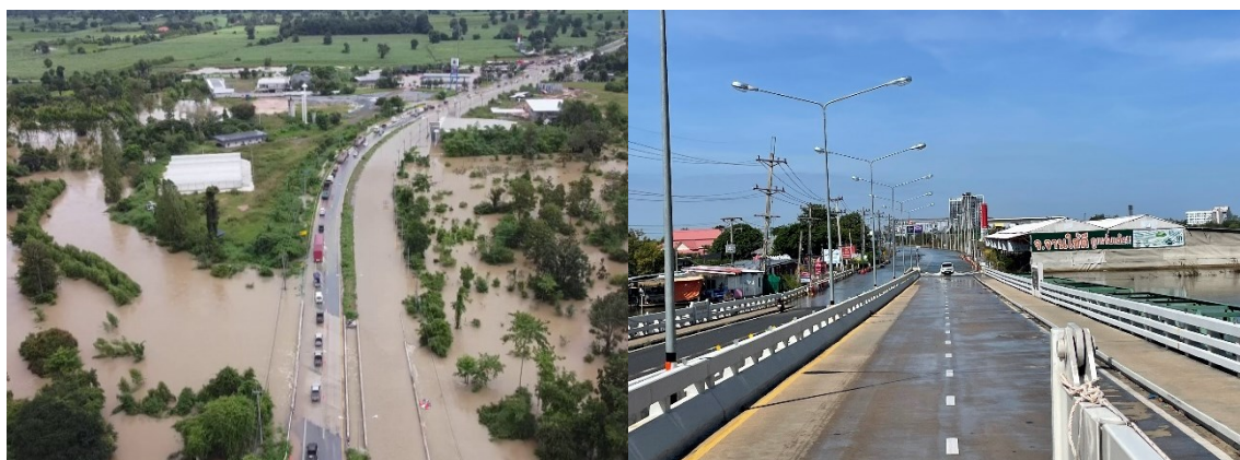
図 5-4 道路嵩上げ政策の導入例 4 (タイ・ウボンラチャタニ)
