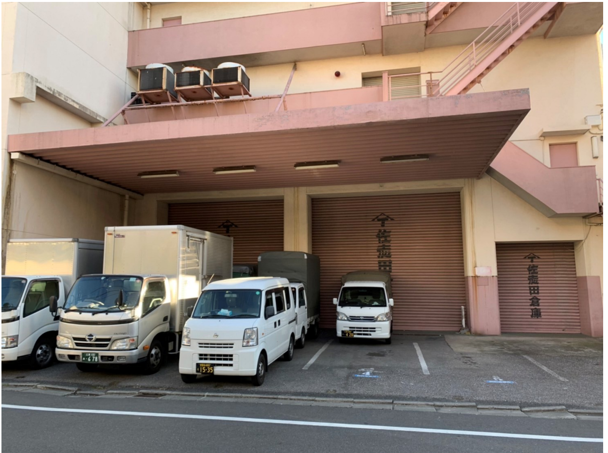
写真 4.2 入出荷バース
