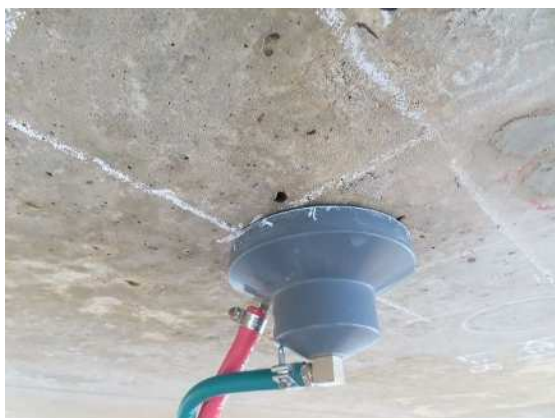
写真-5.22 表層透気試験計測状況
