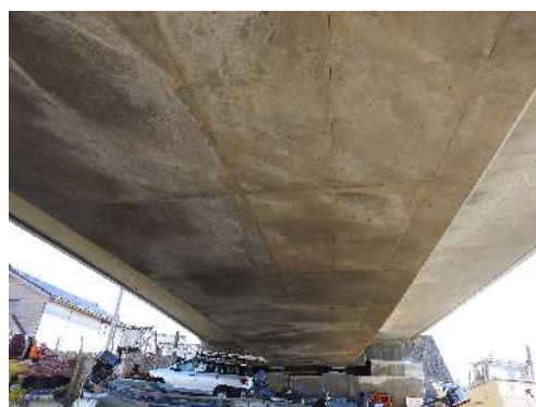
写真-5.18 第3径間床版下面
