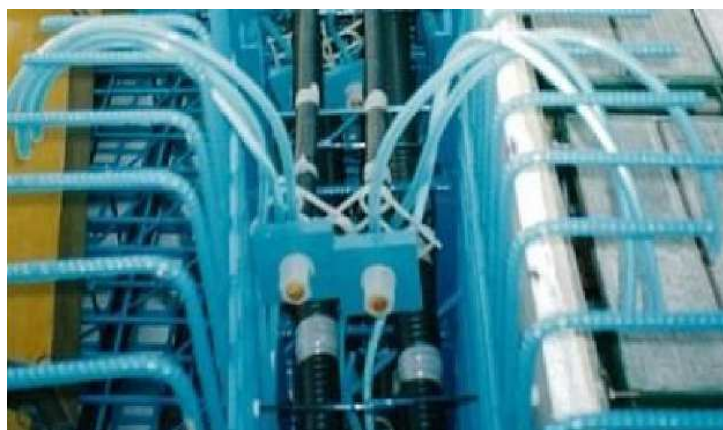
写真-1.3 塩害対策としての高耐食材料の導入
