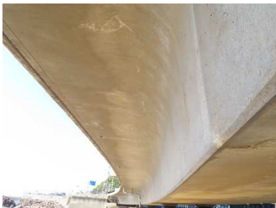
写真-5.11 海側張出し床版の状況
