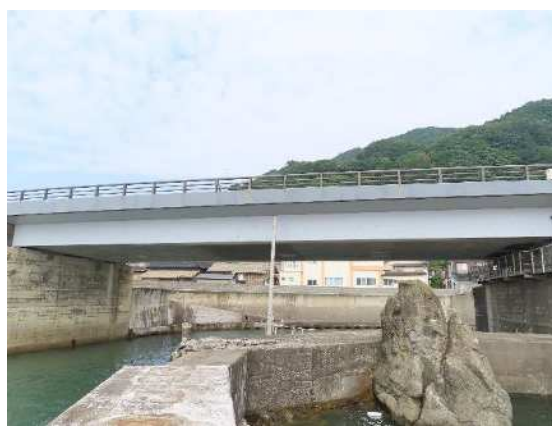
写真-4.4 桁側面 (ひび割れや錆汁の析出なし)
