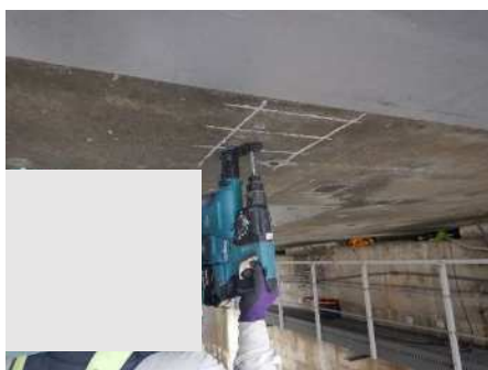
写真-4.9 ドリル法による採取実施状況
