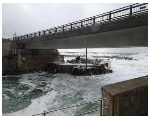
写真-1.4 架橋状況
