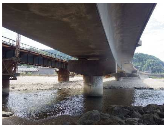
写真-5.6 第1径間桁下状況
