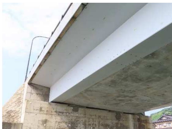
写真-4.5 上部構造端部 (伸縮装置からの漏水なし)
