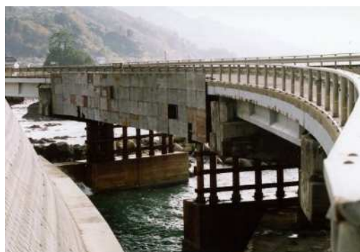
(b) 仮受ベントの設置
