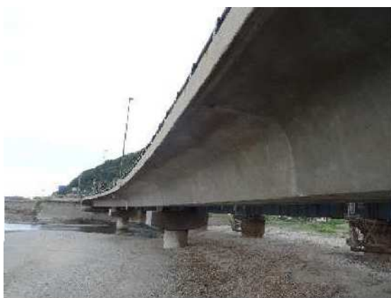
写真-5.1 橋梁全景
