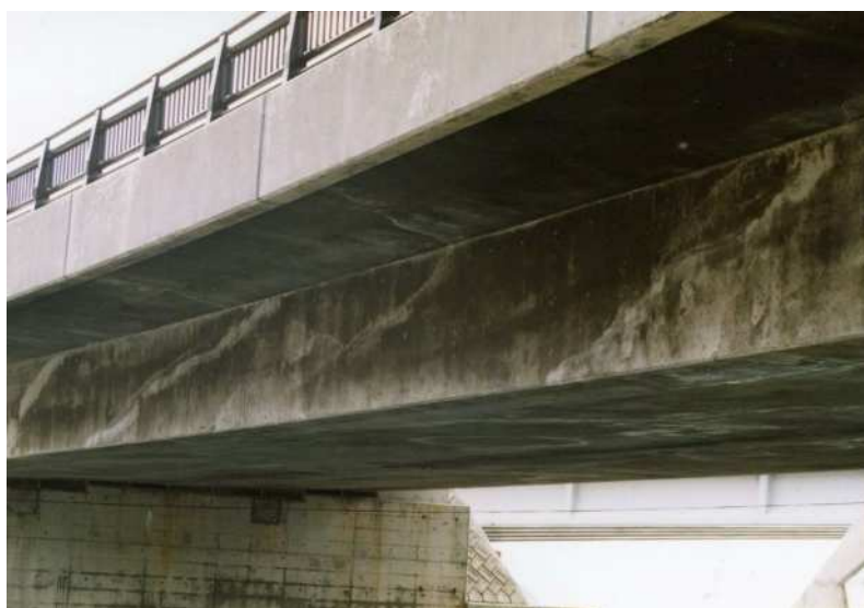
写真-3.5 主桁外面の状況（保護塗装施工前）
