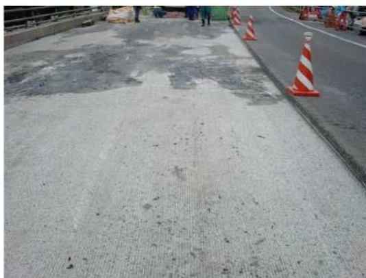
写真-3.17 路面舗装撤去状況
