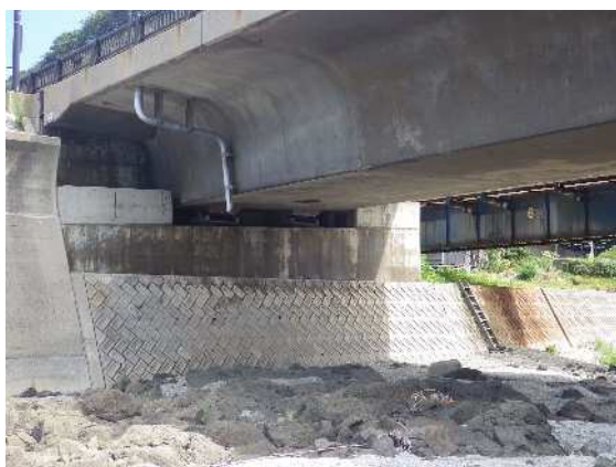
写真-5.5 第1径間海側側面
