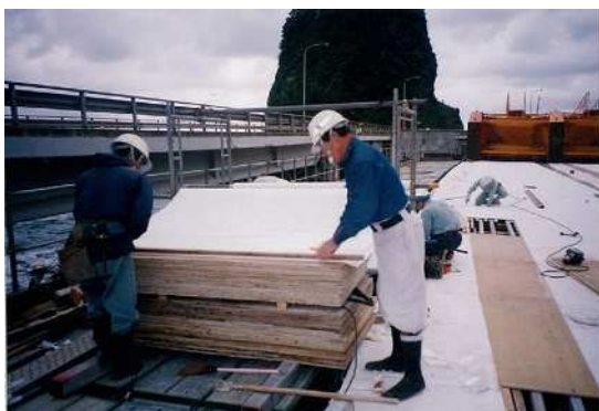
写真-3.3 透水型枠の設置状況
