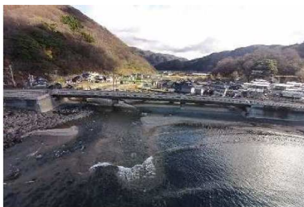
写真-5.2 空撮による橋梁全景
