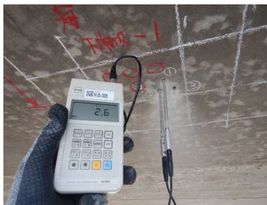
写真 5-21 測定状況 (箱桁内部)
