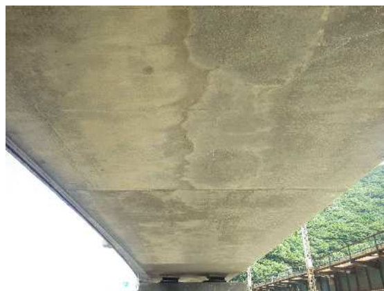
写真-5.8 第3径間床版下面
