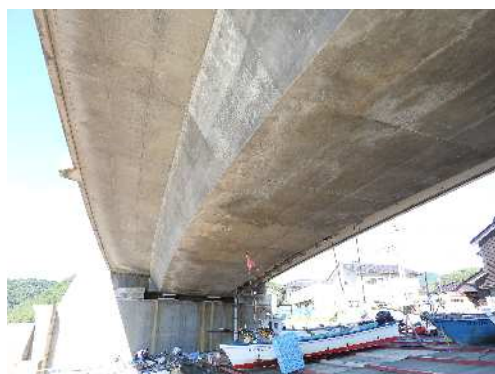
写真-5.15 第1径間桁下状況
