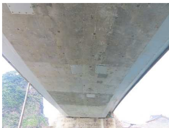
写真-4.3 桁下面 (ひび割れや錆汁の析出なし)
