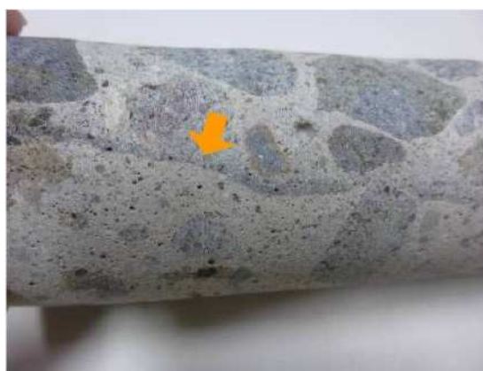
写真-3.12 コールドジョイント部のコア
