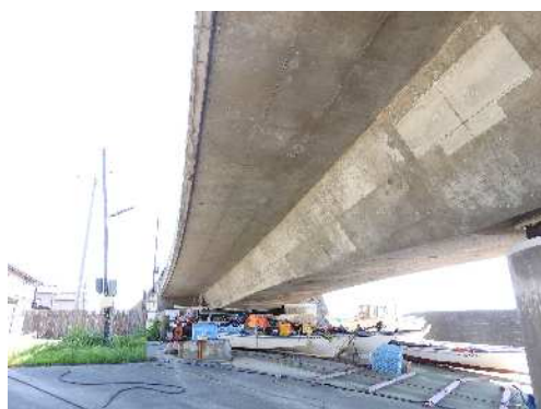
写真-5.17 第3径間桁下状況
