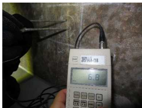
写真-4.8 測定状況（箱桁内部）
