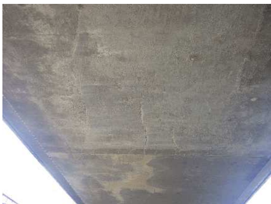
写真-5.7 第1径間床版下面
