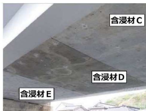
写真-3.22 表面含浸材の施工状況
