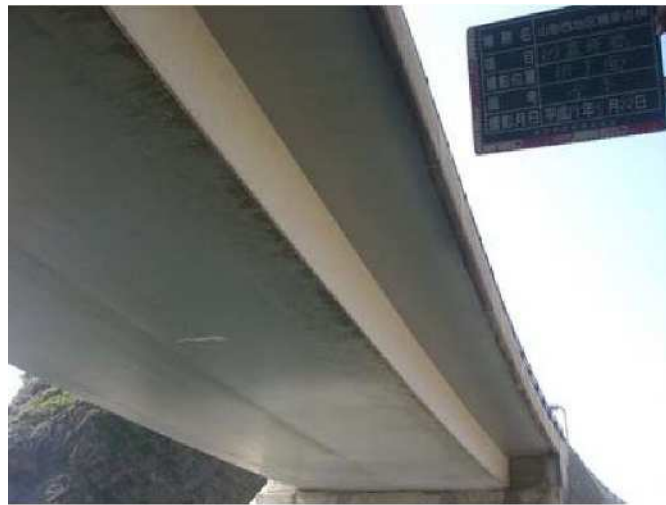
写真-2.4 箱桁外面の保護塗装
