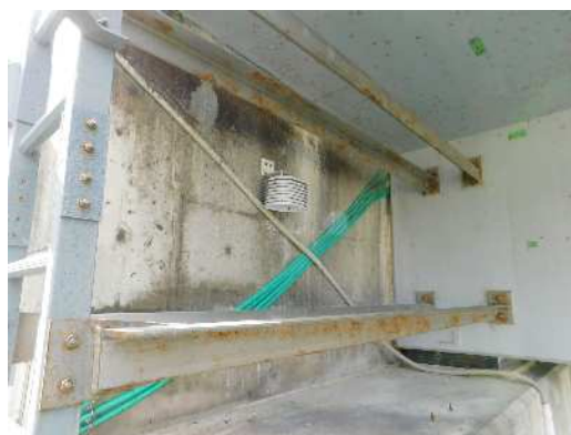
写真-4.14 箱桁外部の温湿度計
