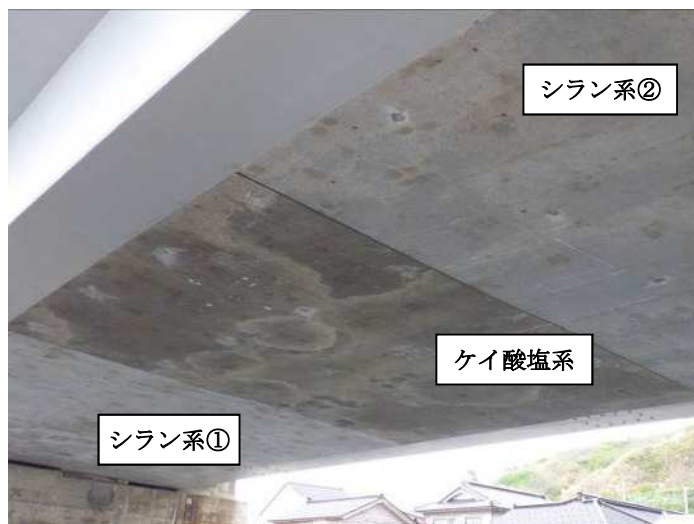
写真-4.1 含浸材の塗布状況
