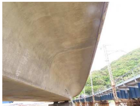
写真-5.12 山側張出し床版の状況
