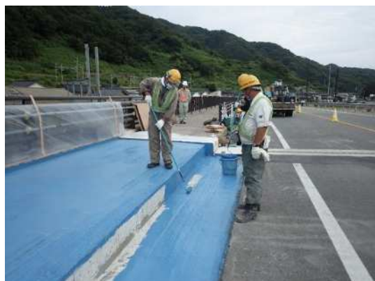
(a) 歩道部の防水工
