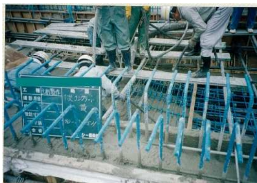
写真-3.4 コンクリートの打設状況
