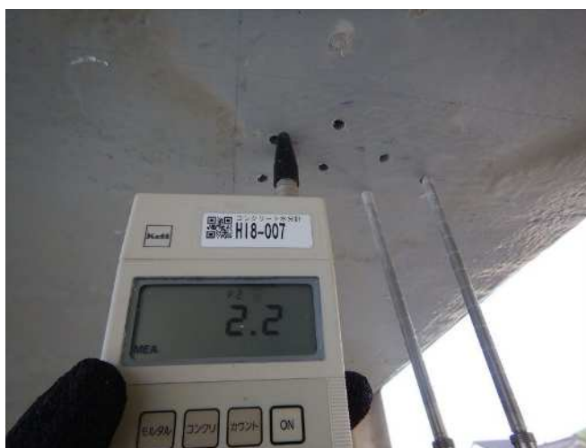
写真-4.11 測定状況（箱桁外面 表面被覆部）
