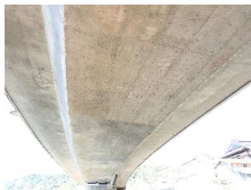
写真-5.16 第1径間床版下面
