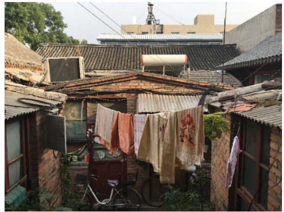
屋上エアコン外機、物干し場
