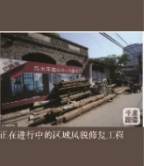
3 正在进行中的环境风貌修复工程。
