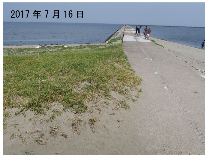
写真-2.1.2 防波堤上に覆い被さった砂
