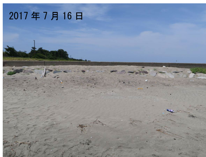
写真-2.1.10 捨石付近での堆砂状況
