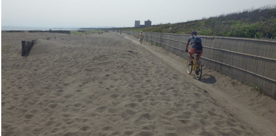
図-1.1.2 海岸背後の遊歩道への飛砂の堆積（神奈川県 湘南海岸）
