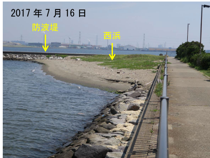
写真-2.1.1 埋立地護岸から望む西浜
