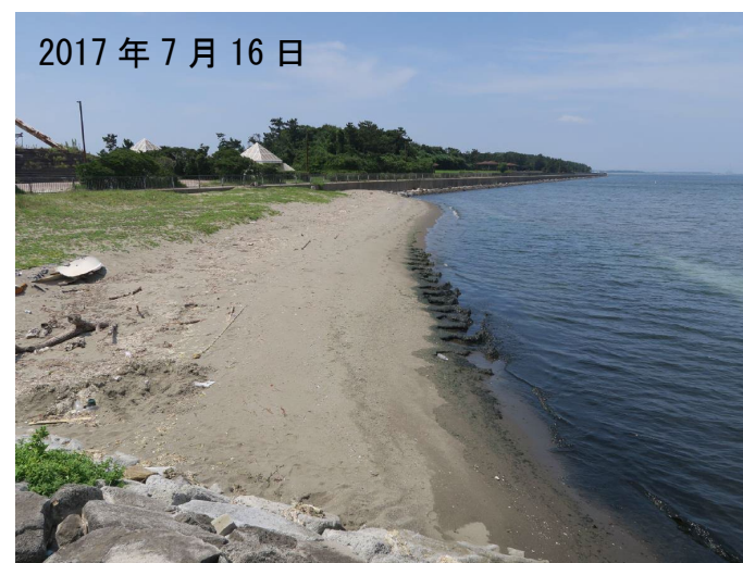
写真-2.1.3 防波堤上から望む西浜
