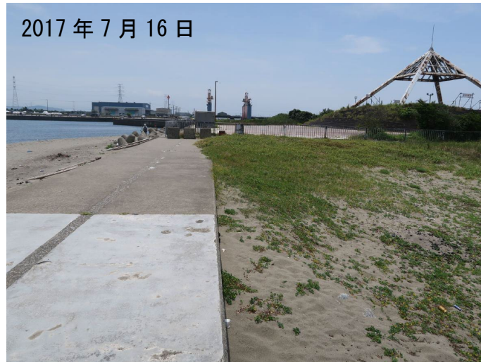
写真-2.1.4 防波堤に被さった砂（南向き）
