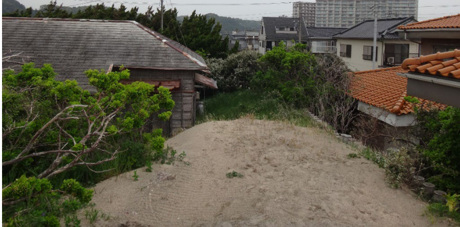
図-1.1.3 海岸背後の住宅地への飛砂の堆積（千葉県 御宿海岸）
