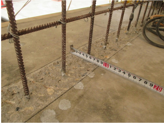
(a) 打継ぎ位置の目荒し
