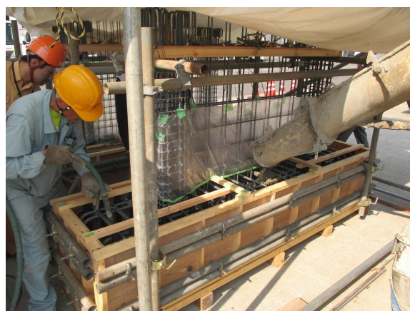
(d) コンクリート打設
