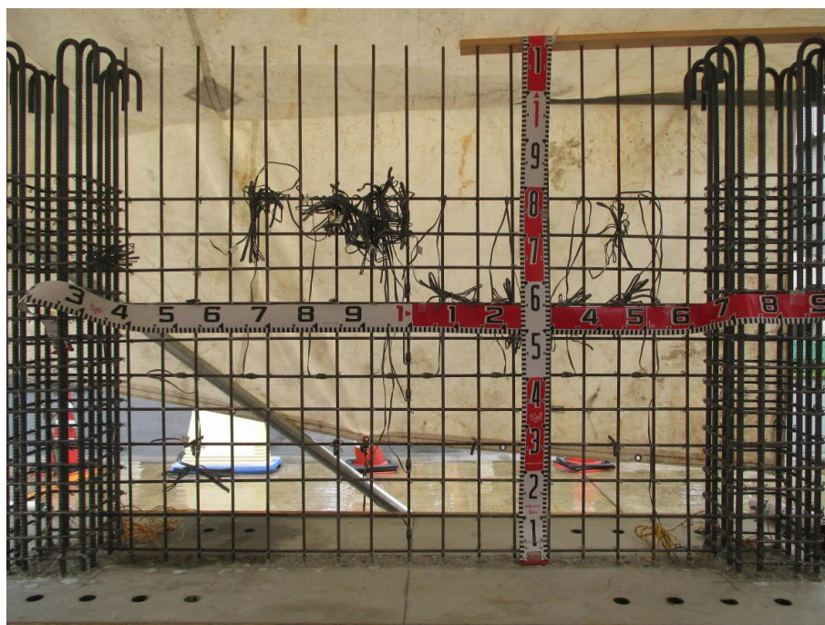
写真 3. 1-3 試験体 T85-p05-D6-S の壁配筋状況
