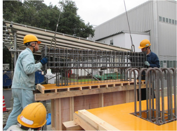
(b) 加力スタブ鉄筋かごの落とし込み
