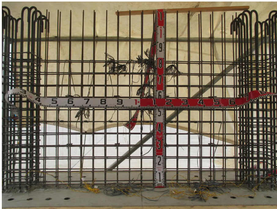
写真 3.1-2 試験体 T85-p10-D6-W の壁配筋状況
