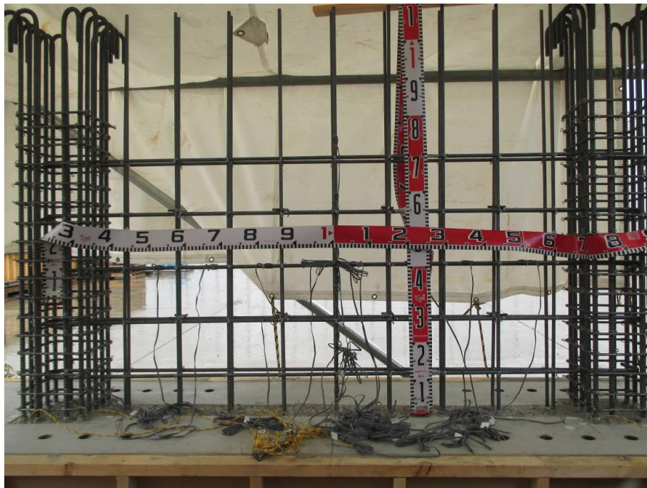
図 3.1-4 試験体 T100-p10-D10-W の壁配筋状況
