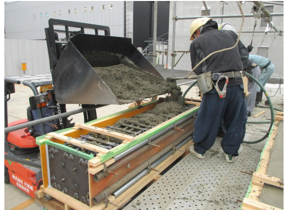
(d) コンクリート打設
