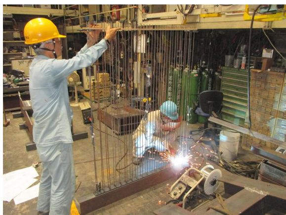
(a) 壁縦筋かごの製作
