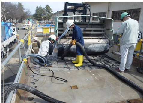
写真-5.4.1 ウォータージェット施工状況
