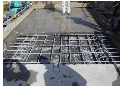
写真-5.4.2 ウォータージェット施工後
