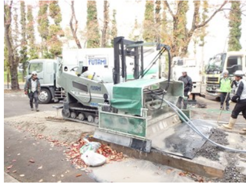
写真-3.3.2 ウォータージェット施工状況
