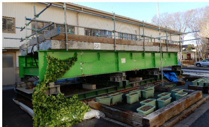
写真-4.2.1 RC床版供試体の外観
