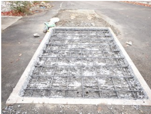
写真-3.3.3 ウォータージェット施工後
