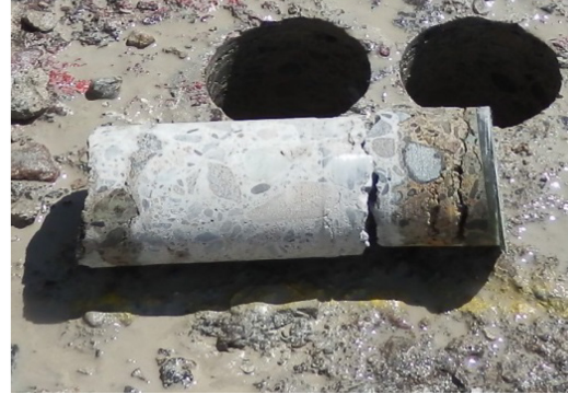
写真 1.1.2 コアのひび割れ 19)
