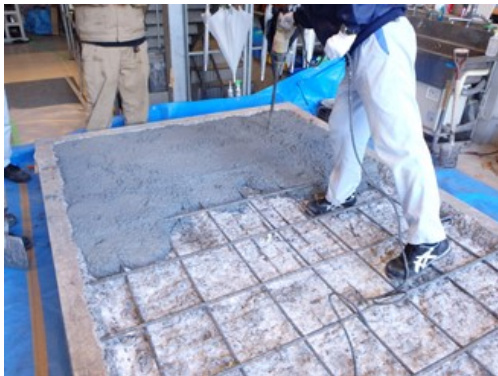
写真-3.3.5 LMC 打込み状況
