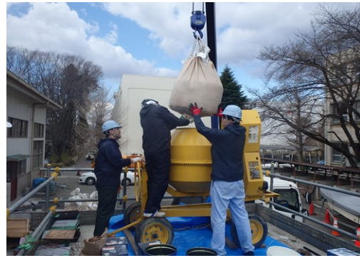
写真-5.4.4 LMCの練混ぜ状況
