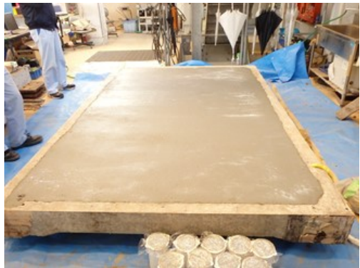
写真-3.3.6 LMC 打込み完了後
