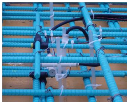
写真-4.2.3 埋込み型ひずみ計の設置状況
