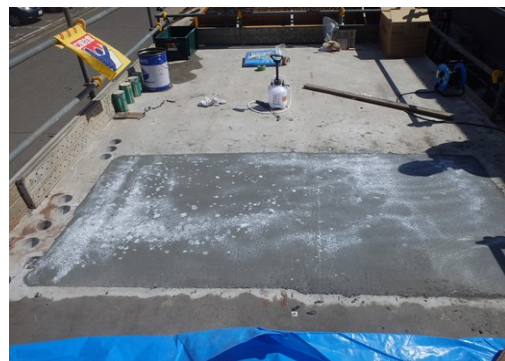
写真-5.4.6 LMCの打込み完了後
