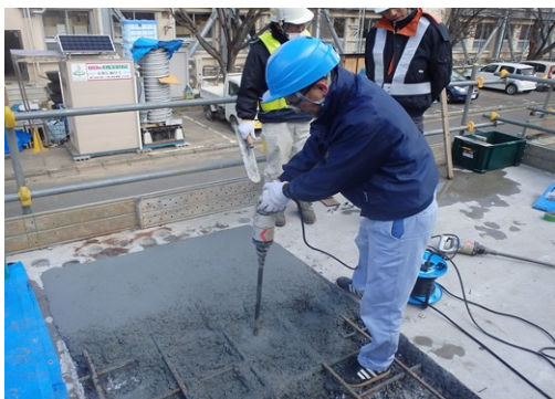
写真-5.4.5 LMCの打込み状況
