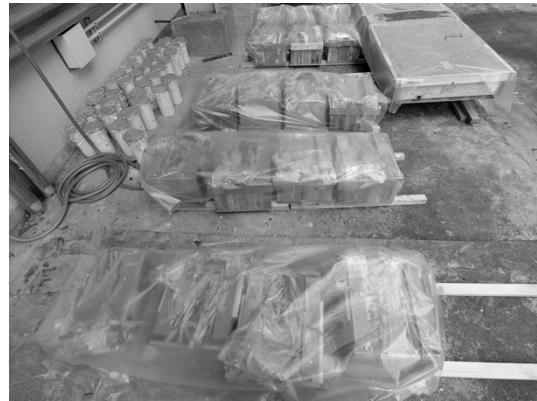
写真 1-10 コンクリート養生 (接合部)
