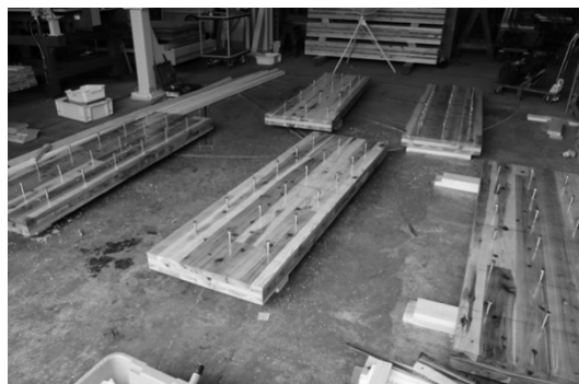
写真 1-2 せん断キー(ラグスクリュー) 打込み後
