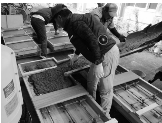
写真 1-5 コンクリート打設中 (複合床スラブ)
