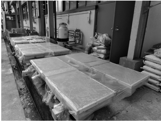
写真 1-7 コンクリート養生 (複合床スラブ)
