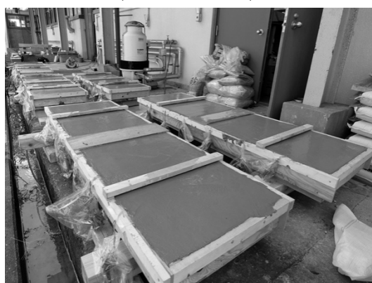
写真 1-6 コンクリート打設後 (複合床スラブ)
