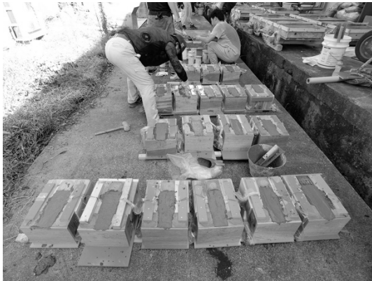
写真 1-9 コンクリート打設後 (接合部)
