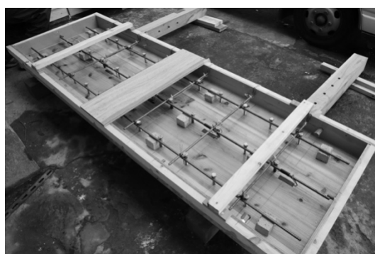
写真 1-4 打設前 (複合床スラブ)
