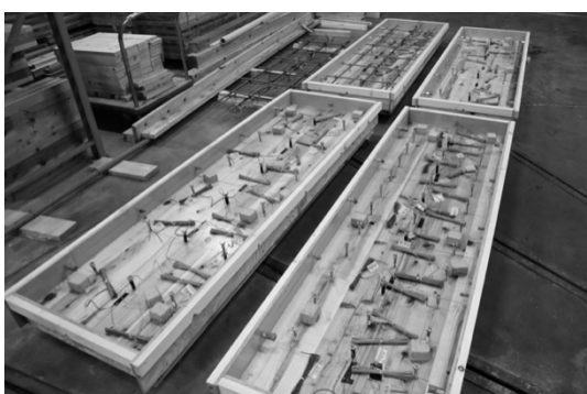
写真 1-3 ひずみゲージ貼付け中 (複合床スラブ)
