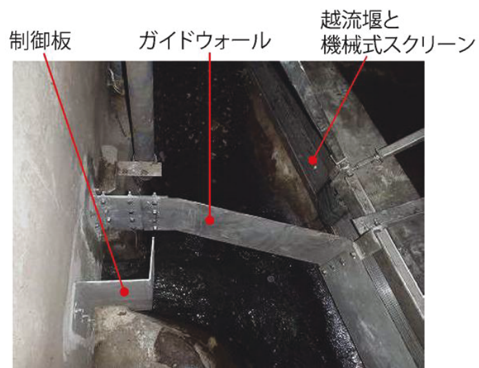
写真 6.4 機械式スクリーンに水面制御装置を設置
