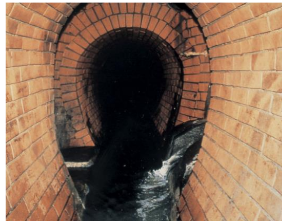
写真 2.1 神田下水の現況
