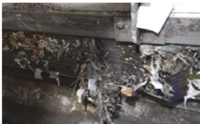
写真 6.12 ケース A のスクリーン付着状況
