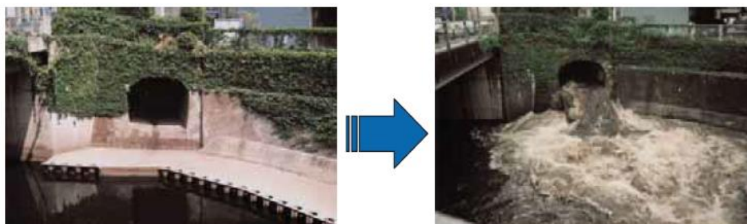
写真 2.3 雨水吐き室の晴天時（左）と雨天時の未処理下水放流状況（右） 21)
