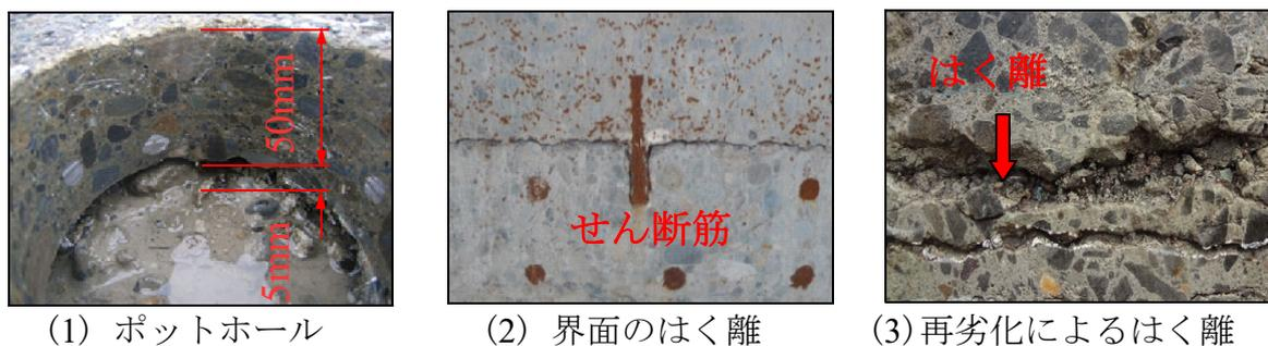
写真－ 5.2 SFRC 上面増厚補強法における界面のはく離
