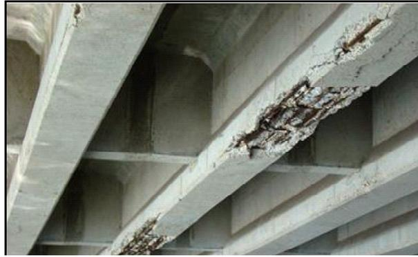
写真－ 4.1 曲げ領域の損傷状況<sup>4.7)</sup>
