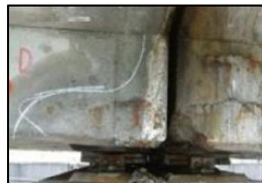
(1) ひび割れ・鋼材の腐食 (2) 主げたのひび割れ (3) けた端部の損傷
