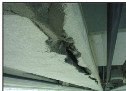
(3) 再劣化によるひび割れ (4) 再劣化によるひび割れによる鉄筋露出
