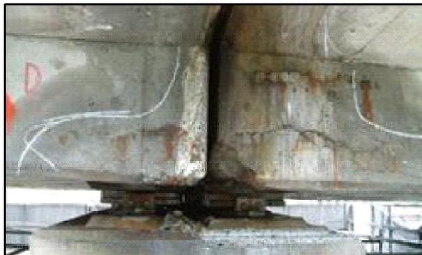
写真－ 4.2 せん断領域の損傷事例<sup>4.7)</sup>
