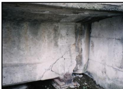
写真－ 2.3 主げた支点付近の損傷<sup>2.18)</sup>
