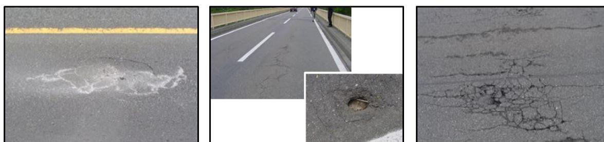
(1) 石灰分の滲出 (2) ポットホールの発生 (3) 5mm 程度のひび割れ
