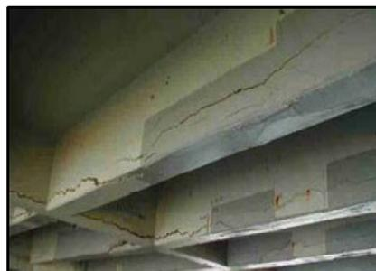
(1) 補強鋼板の再劣化による腐食・うき (2) 表面保護した部材のひび割れ損傷
