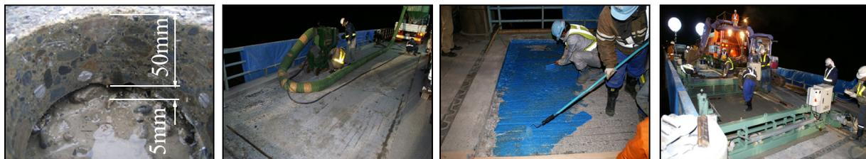
(1) 界面のはく離 (2) 舗装撤去 (3) 付着用接着剤 (4) コンクリート打設
