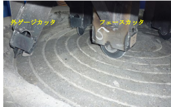
図 4.1.9 フェースカッタおよび 外ゲージカッタの作動状況
