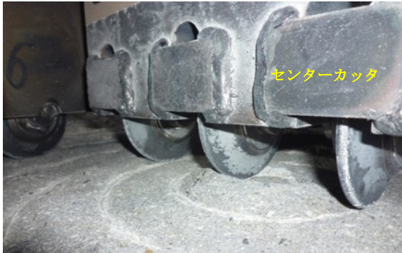
図 4.1.8 センターカッタの作動状況
