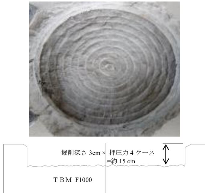
図 4.3.2 F1000 仕上がり状況
