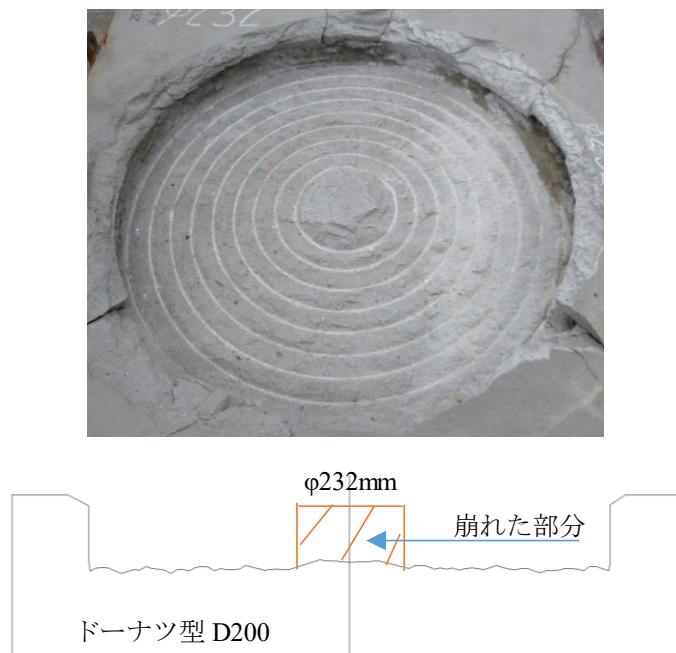
図 4.3.3 D200 仕上がり状況
