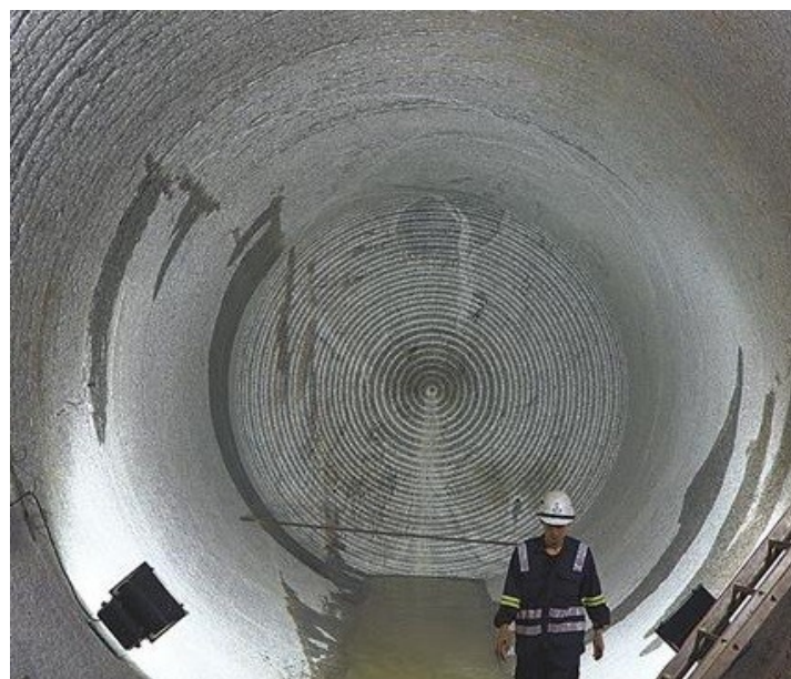
図 2.2.5 カッタの溝掘り・隣接剥離破碎
