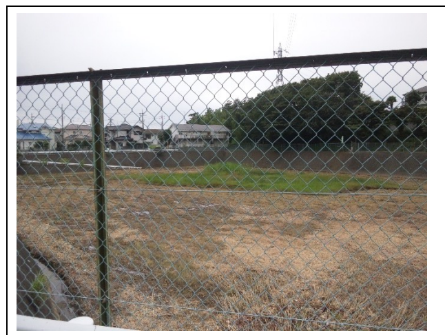
図3-36. 高南台調整池（フェンスで囲まれている状況）
