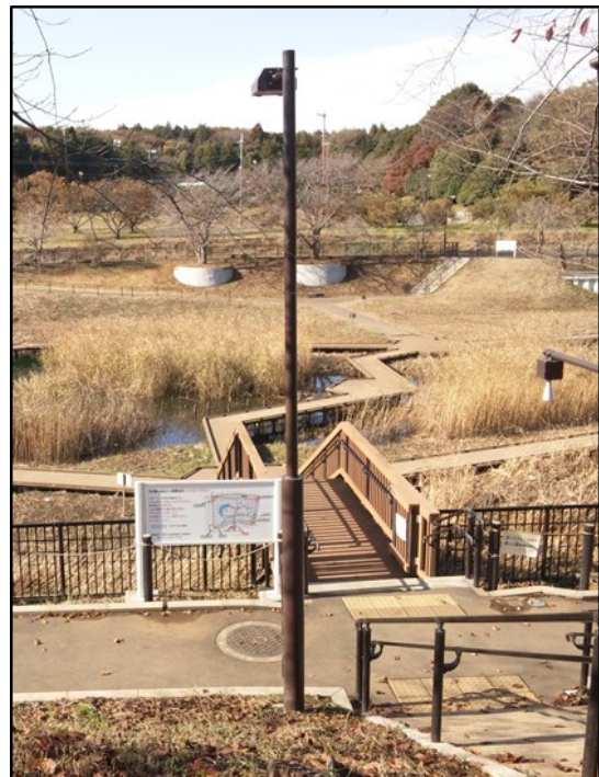
写真3-9. ハザードランプ (調整池 No. D1 こてはし台調整池)
