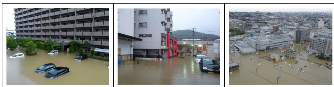
写真1-1. 岡山市内の内水氾濫 (平成 30 年 7 月豪雨)
