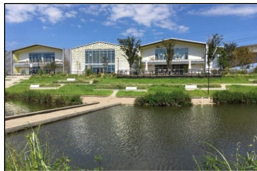
写真3-4. 調整池 No. E1 北部中央2号調整池（アクアテラス）（改修整備後） ※参照：日経BP社
