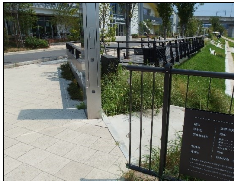
写真3-10. チェーンによる大雨時の立入禁止措置 1 (調整池 No. E1 北部中央 2号調整池)
