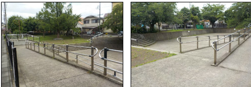
写真3-2. 調整池 No. C1 地産団地調整池 (改修整備後)
