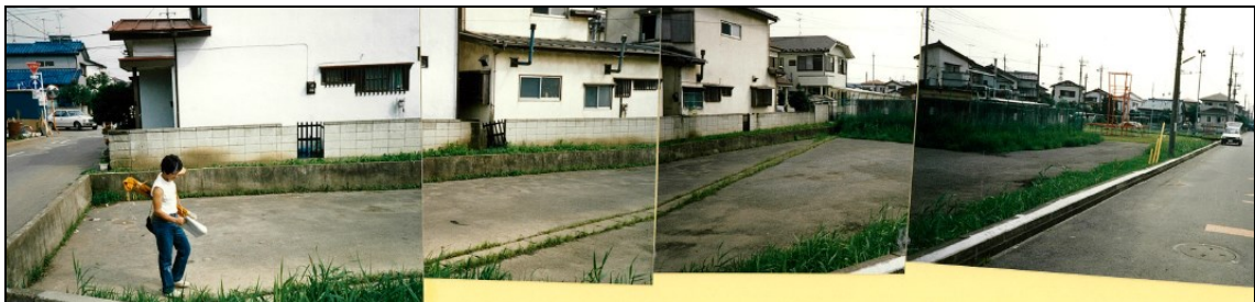
写真3-1. 調整池 No. C1 地産団地調整池 (改修整備前)
