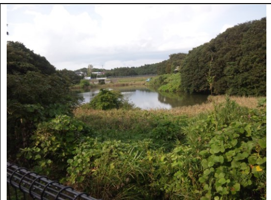
写真1-8. 浦部川調節池
