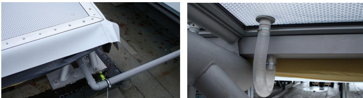
写真2. 3. 1 大型パネルへの細いチューブによる空気供給
