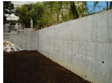
(b) 左 ; CB 擁壁 右 : 新設 RC 擁壁
