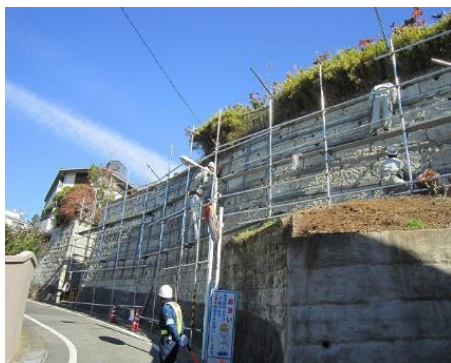
写真2-6 鉄筋挿入工(大谷石擁壁)
