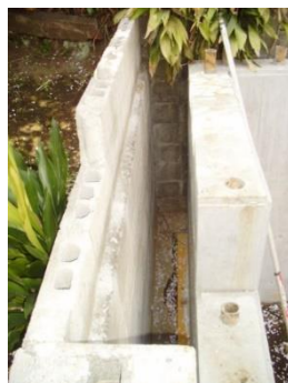
(b) 左 ; CB 擁壁 右 : 新設 RC 擁壁
