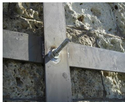
写真2-6 鉄筋挿入工(大谷石擁壁)
