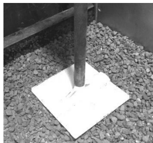
写真 3 - 5 支持地盤作製状況
