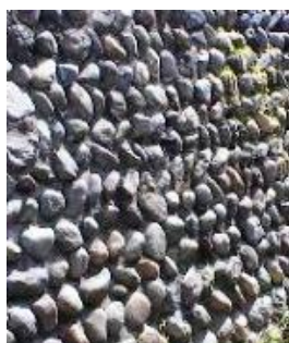
写真2-1 空石積み擁壁
