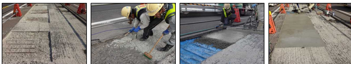
(1)脆弱箇所撤去 (2)浸透性接着剤塗布 (3)付着用接着剤塗布 (4)表面仕上げ ・モルタル打設
