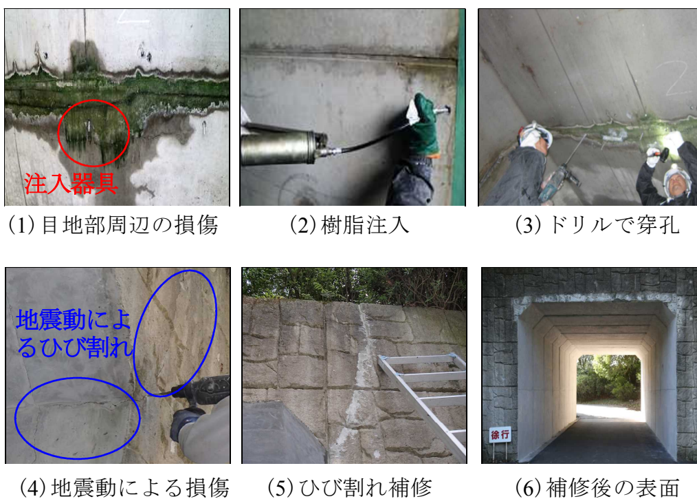
写真－ 7.2 ひび割れ補修状況の一例
