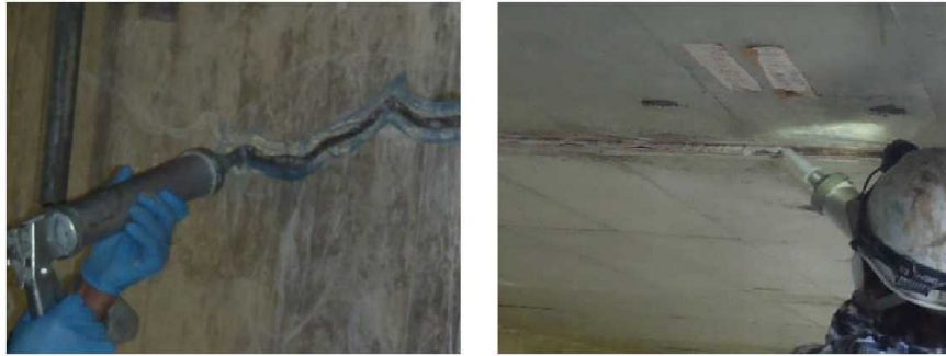
写真－ 2.2 ひび割れ充填工法の施工例 2.22)
