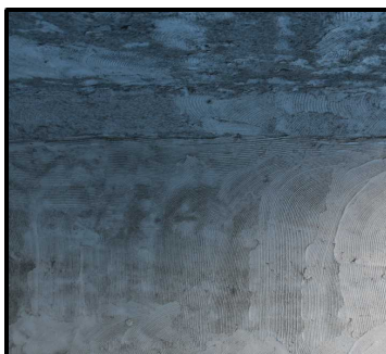
(10)1層目吹付け終了
