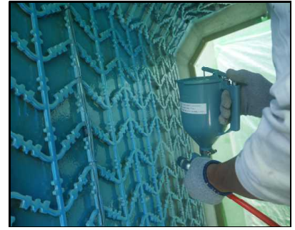
(1) 展張格子筋の設置作業 (2) 展張格子筋の設置終了 (3) 付着用接着剤塗布作業
