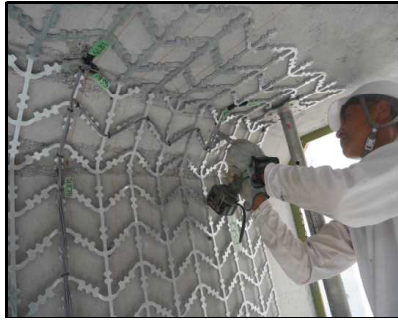
(1) 展張格子筋の設置作業 (2) 展張格子筋の設置終了 (3) 付着用接着剤塗布作業
