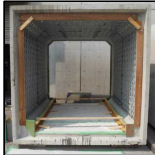
(1) 展張格子筋の設置作業 (2) 展張格子筋の設置終了 (3) 付着用接着剤塗布作業
