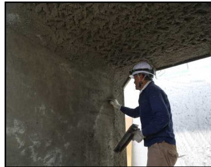
(4) PCM 吹付け作業 (5) コテ作業 (6) 完成
