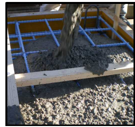
(4)コンクリート打設
