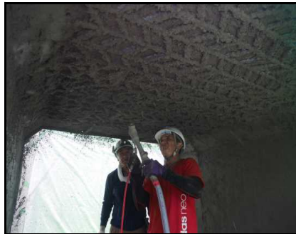
(4) PCM 吹付け作業 (5) コテ作業 (6) 完成
