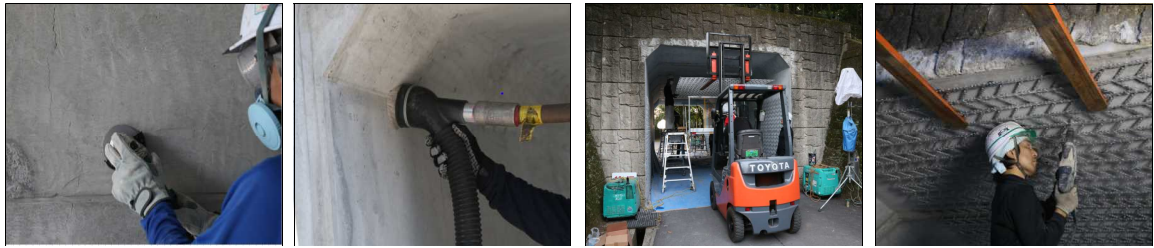
(1) 表面処理 (2) 研掃 (3) 展張格子筋搬入 (4) 展張格子筋設置
