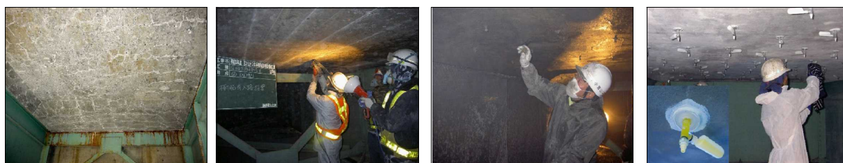
(1) 下面の損傷 (2) 接着剤導入路 (3) 鉄筋配置後増厚 (4) 樹脂注入
