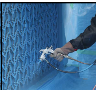
(8)接着剤吹付け
