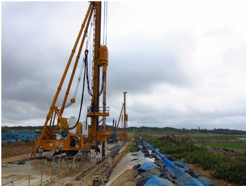
图 3.3 SMW 工法施工状況写真
