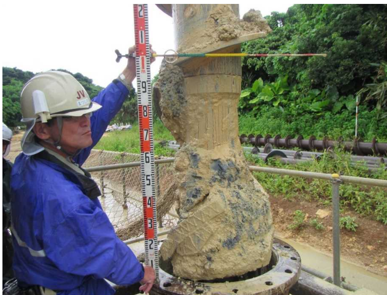
図 1.9 島尻層群泥岩確認状況写真
