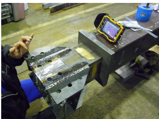
19) 芯材とウイングプレート溶接部の UT 検査
