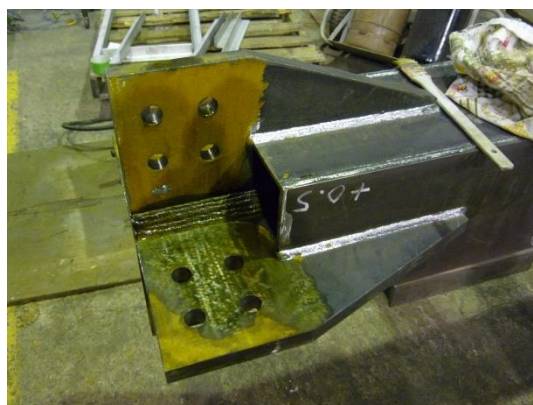
26) 摩擦面処理(錆発生剤の塗布)
