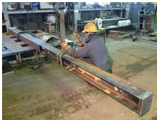
14) 芯材と中鋼管の挿込み状況
