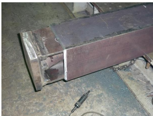
15) 芯材と中鋼管の挿込み状況(2)
