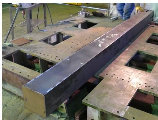
20) 外鋼管の組立溶接(部分溶込み)
