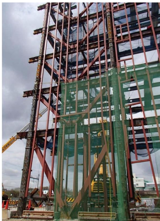
(g) 建て方状況 3 (全景)
