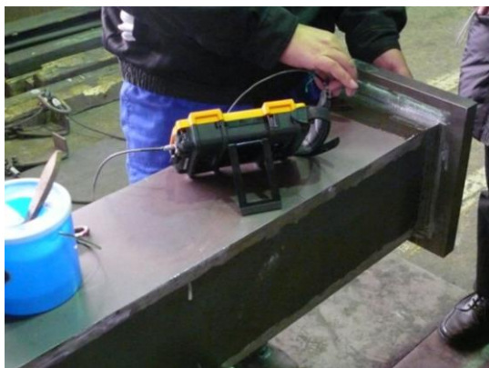
13) 中鋼管と REPL 溶接部の UT 検査
