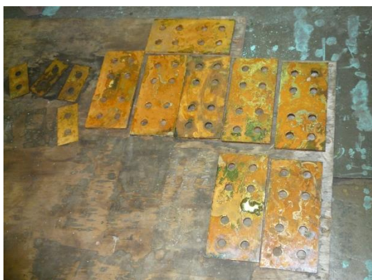
27) スプライスプレートの摩擦面処理
