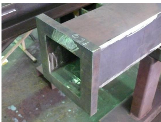
11) 中鋼管と REPL の完全溶込み溶接(2)
