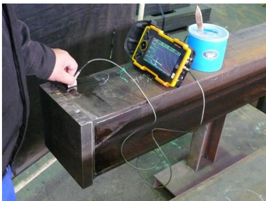
5) 芯材と EPL 溶接部の UT 検査
