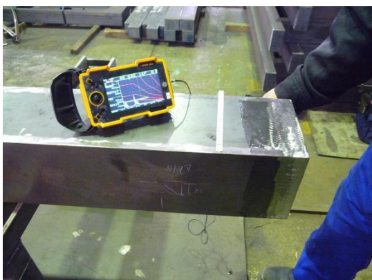
17) 中鋼管と EPL 溶接部の UT 検査
