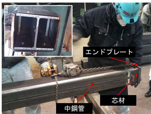
(c) 中鋼管への芯材の挿入状況
