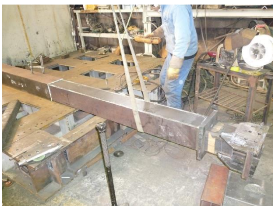
21) 中鋼管と外鋼管の挿込み状況
