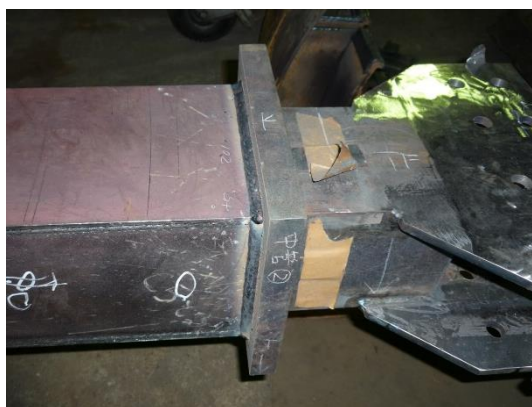
22) 外鋼管と REPL の完全溶込み溶接
