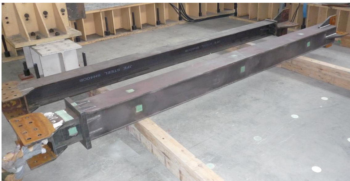
28) 折返しブレース完成状況
