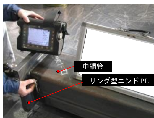
(b) 中鋼管とリング型エンド PL の突合せ溶接状況
