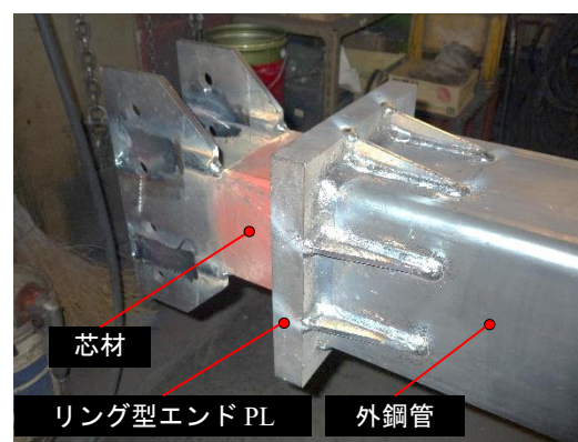
(d) 外鋼管とリング型エンド PL の突合せ溶接状況
