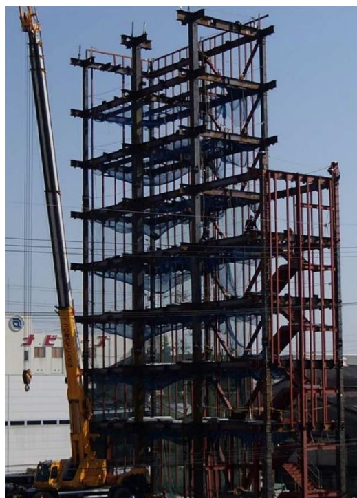
(h) 建て方状況 4 (全景)
