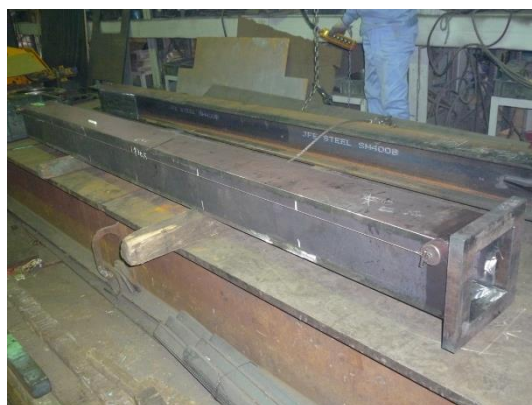
12) 中鋼管と REPL の完全溶込み溶接(3)
