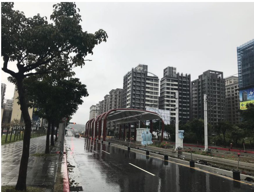
写真 5.4 建設中の地上駅（G5 駅）
