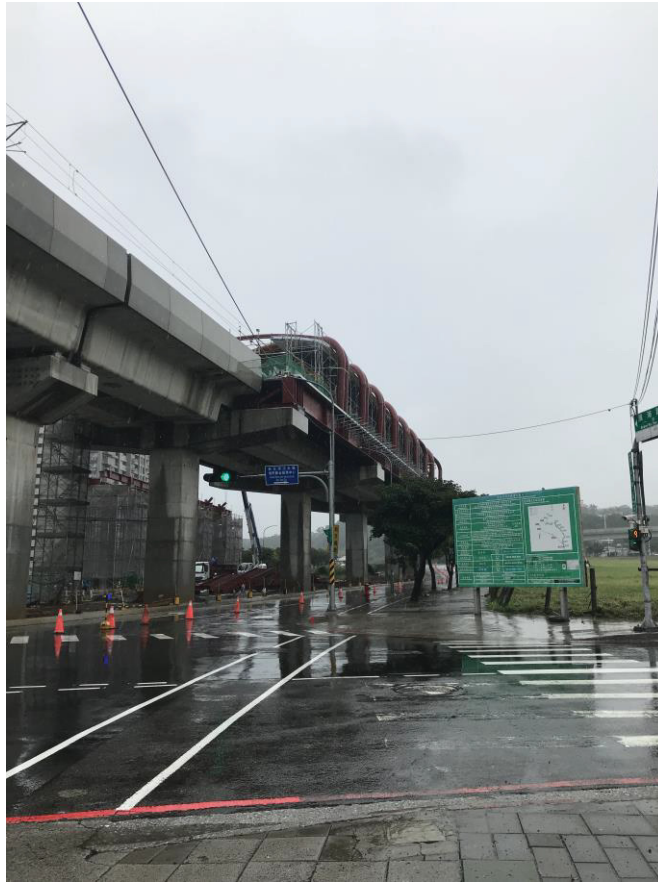
写真 5.3 建設中の高架駅（G4 駅）
