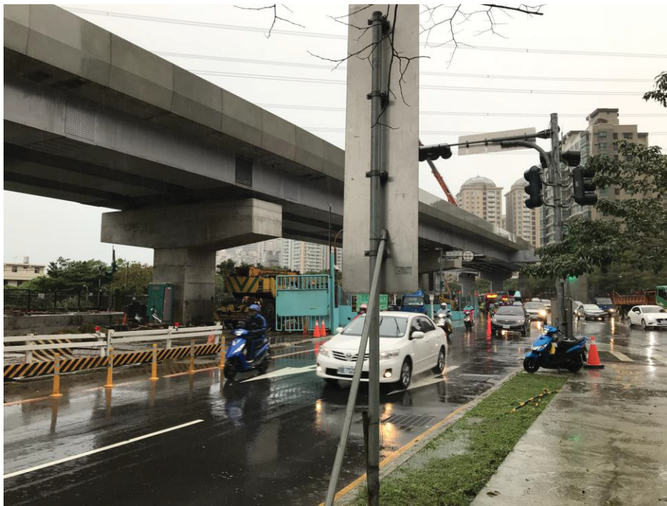
写真 5.2 建設中の高架部
