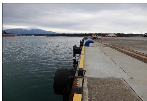
写真-6-1-2 係船柱・防舷材追加例(酒田港)
