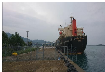
写真-1-2-2 SOLAS フェンス(新宮港)
