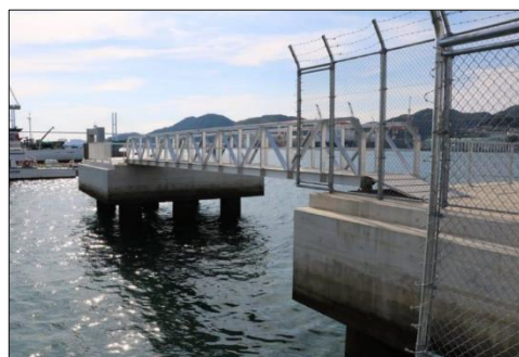
写真-6-1-1 岸壁延長の例(長崎港)
