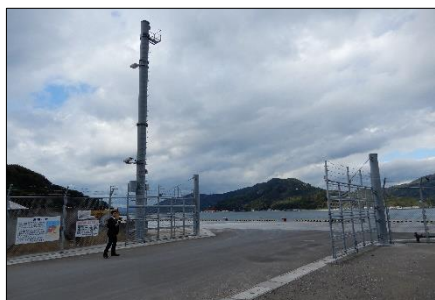
写真-1-2-1 SOLAS フェンス(宇和島港)
