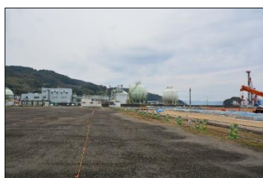
写真-7-2-60 駐車場予定地①
