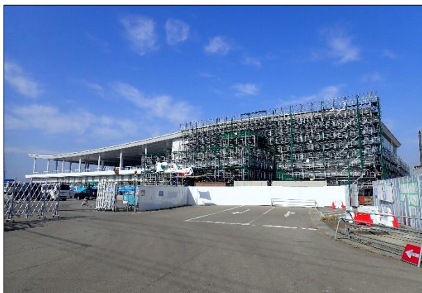
写真-5-2-1 建設中の金沢港クルーズターミナル (2019年10月)
