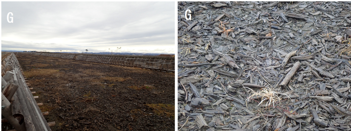
図 3.23 現地写真(2018年3月9日)
