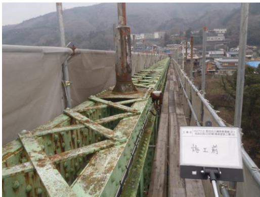
写真 6 - 3 補剛桁再塗装前
