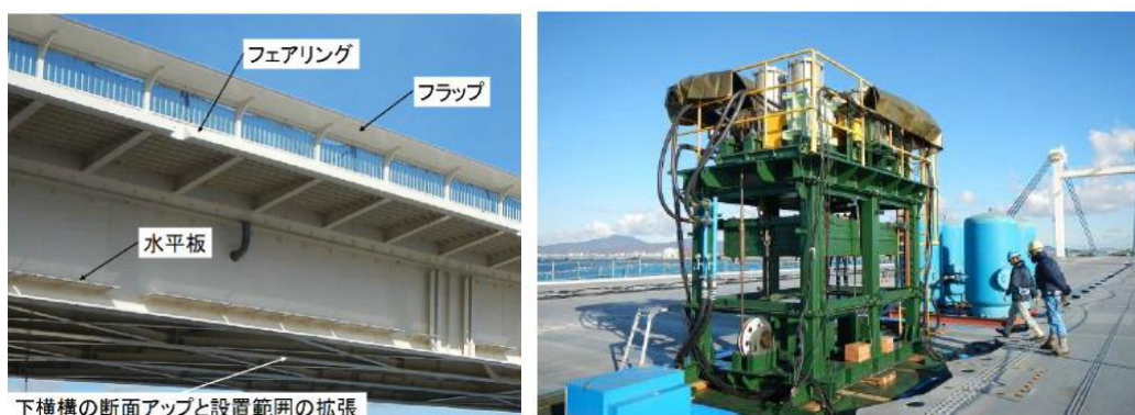
写真5-7 左 耐風対策フラップ、フェアリング、 右 起振機
