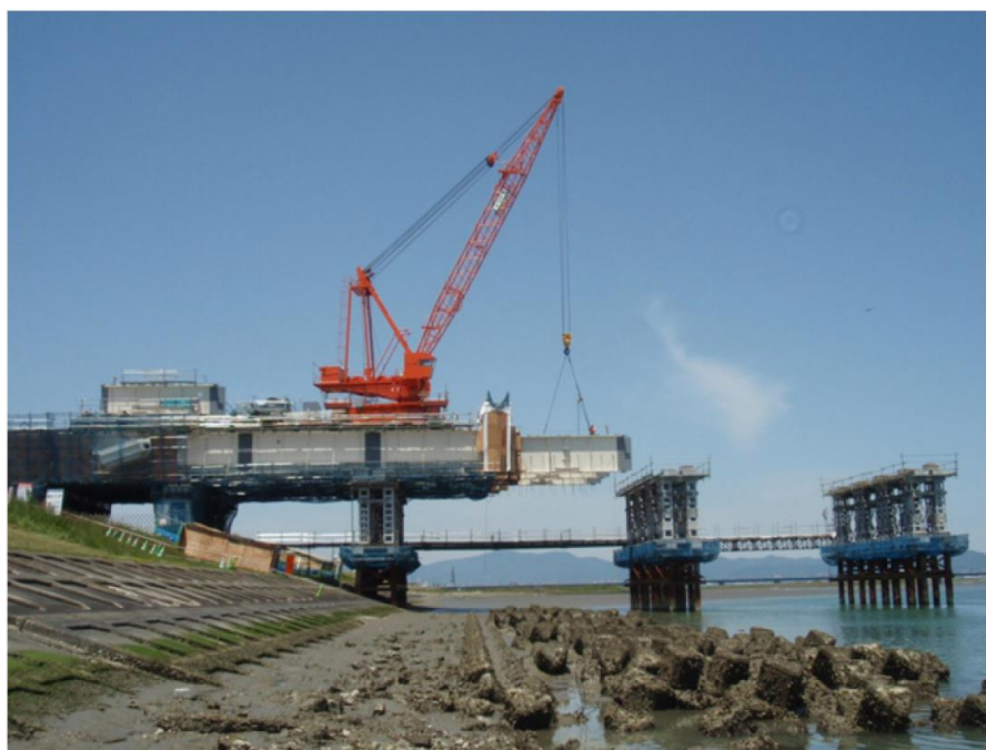
写真 5 - 1 2 側径間架設
