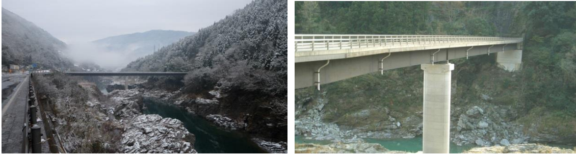
写真8-57 国見山橋 (徳島県橋の博物館とくしま HP より)
