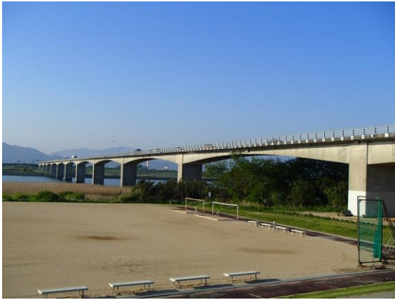
写真6-14 名田橋全景河口左岸側
