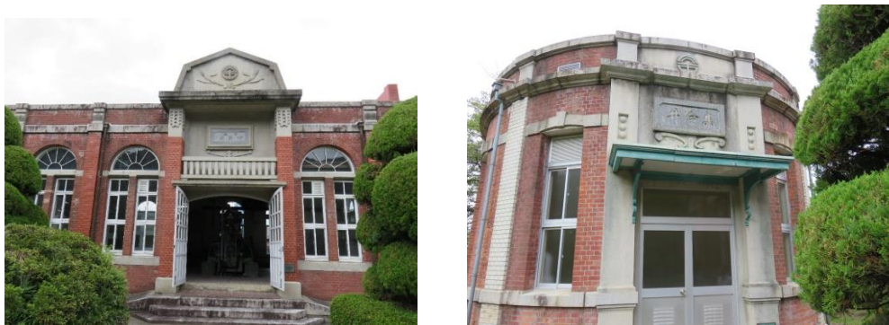
写真 2 - 6 佐古配水場（徳島市）
