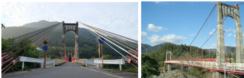
写真 8-4 4 美濃田大橋 (徳島県橋の博物館とくしま HP より)
