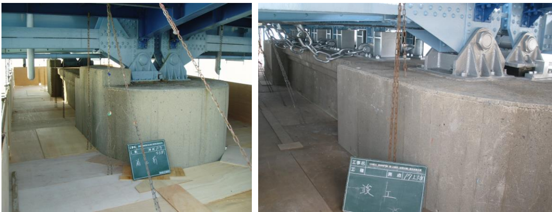
写真 6 - 7 吉野川橋の耐震連結装置の設置状況
