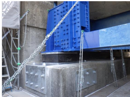
写真 6-29 ゴム支承に取り替え
