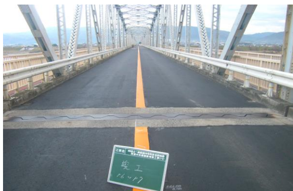
写真 6 - 9 舗装補修完成状況
