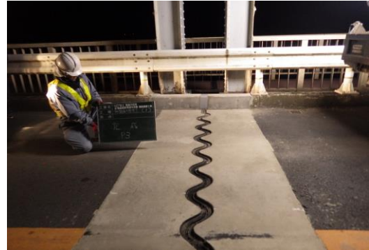
写真 6-13 伸縮継ぎ手補修後
