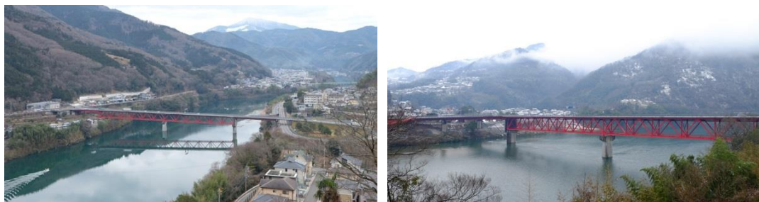
写真8-51 池田大橋（徳島県橋の博物館とくしまHPより）
