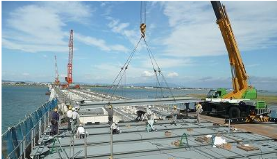
写真 5-5 サンドイッチ床板の架設
