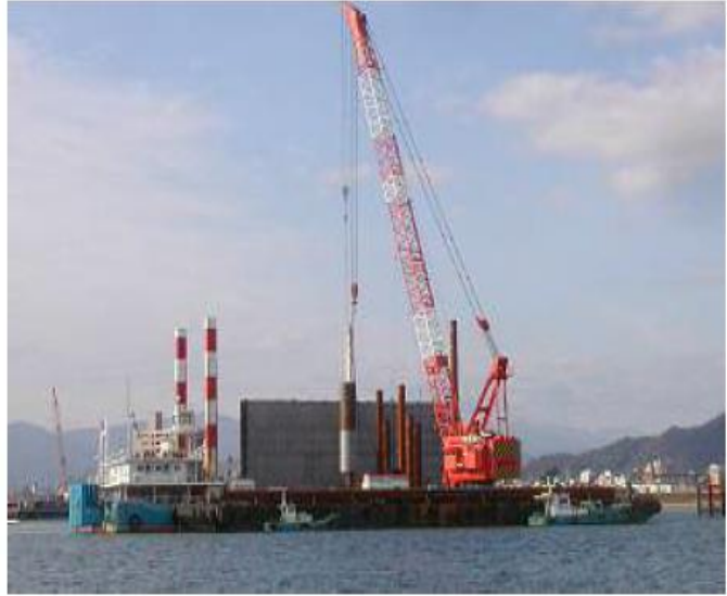
写真5-10 杭施工
