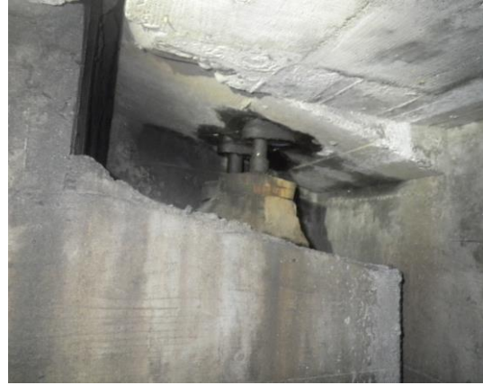
写真6-15 ヒンジ部アンカーボルト
