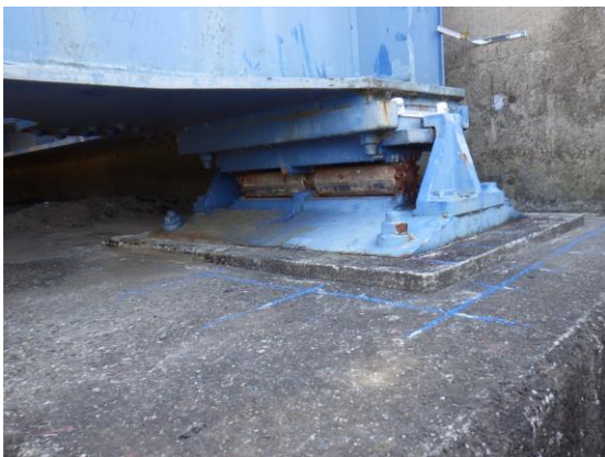
写真 6-26 支承取り替え前
