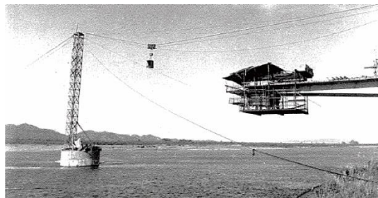
写真8-11 上部工の施工状況（徳島県名田橋工事報告） 運搬設備（徳島県名田橋工事報告）
