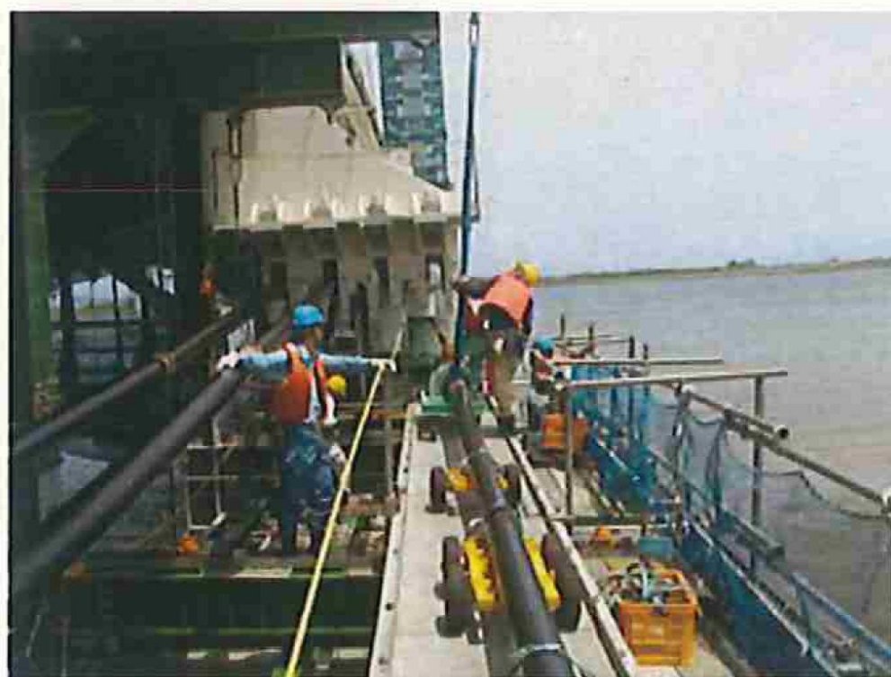
写真5-15 下ケーブル引込み 横取り
