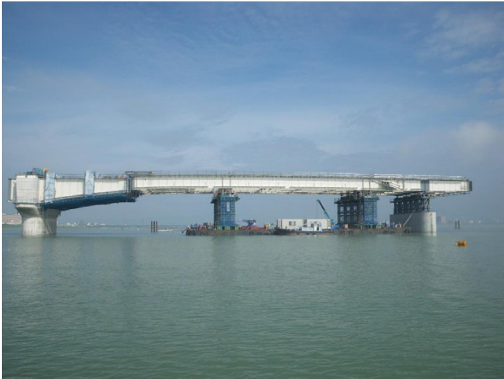
写真 5 - 1 3 台船架設
