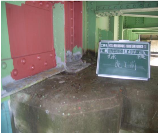
写真 6 - 1 補修前の支保
