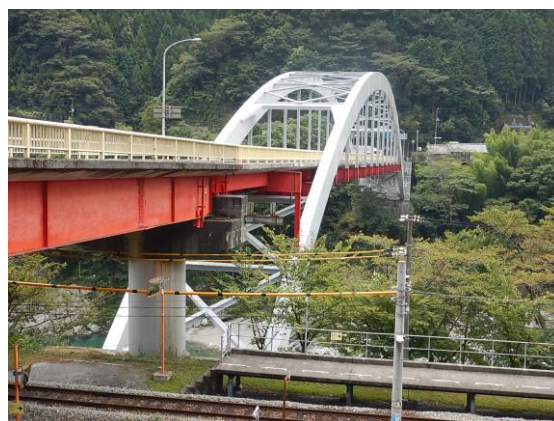
写真 6-25 再塗装後全景
