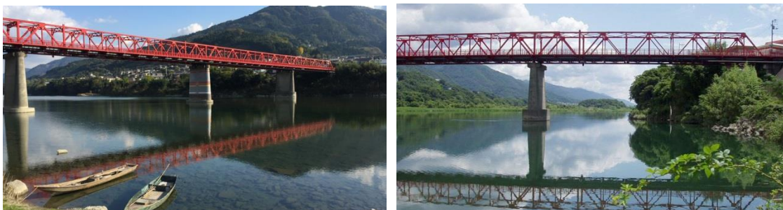
写真8-47 三好大橋（徳島県橋の博物館とくしまHPより）
