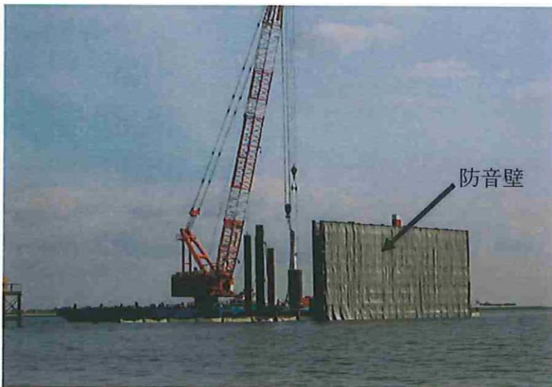
写真5-11 台船施工 防音管や防音壁ほか
