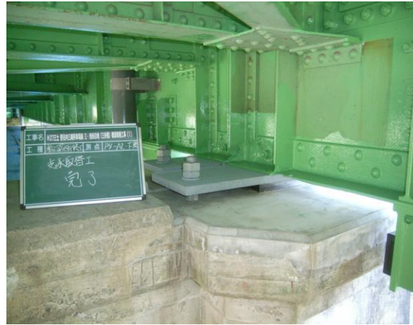
写真 6 - 2 補修後の支保
