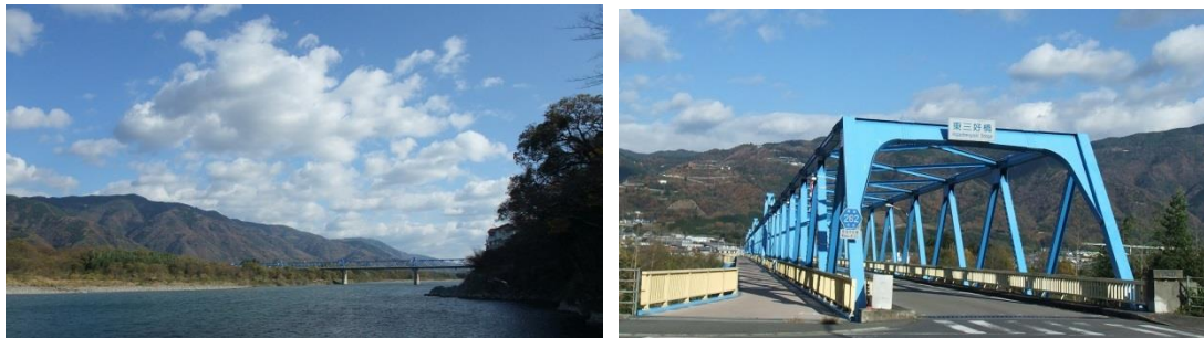
写真 8-4 1 東三好橋（徳島県橋の博物館とくしま HP より）
