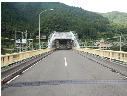
写真 6-20 大歩危橋再塗装足場
