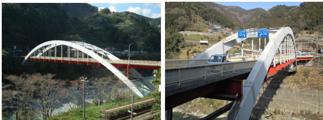
写真8-61 大歩危橋（徳島県橋の博物館とくしまHPより）
