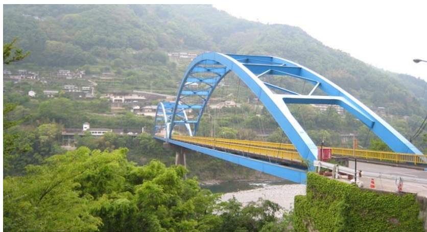
写真8-56 祖谷口橋 (徳島県橋の博物館とくしまHPより)
