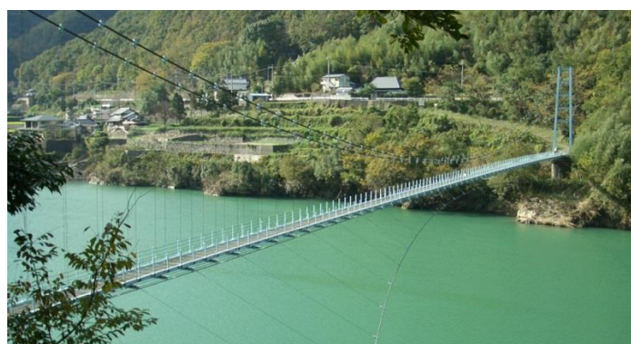
写真8-49 敷之上橋（橋の博物館とくしまHPより）
