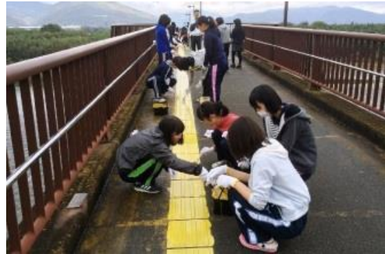
点字ブロックの塗装（ふれあい橋）
