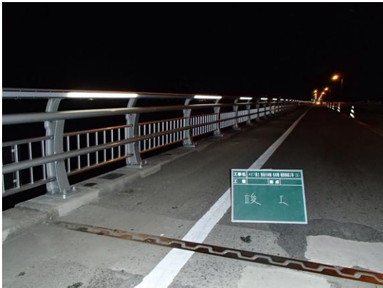
写真6-19 高欄嵩上げとLED照明
