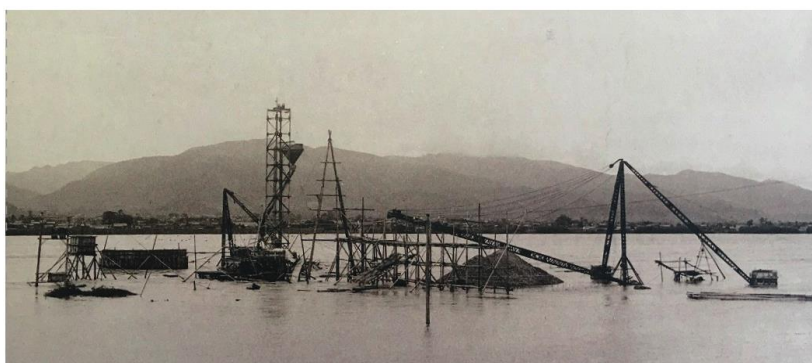
写真8-16 ジェーン台風による被害(昭和25年9月3日)(阿波中央橋架設工事報告書)
