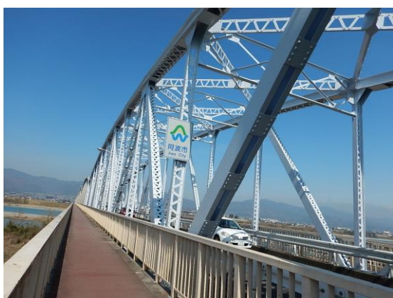
写真 6 - 1 1 再塗装完成状況
