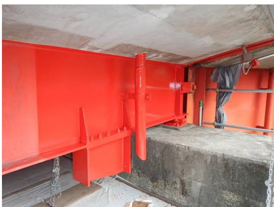
写真 6-24 桁部再塗装
