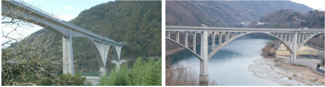
写真 8-5 0 池田へそつ湖大橋(徳島自動車道) (橋の博物館とくしま HP より)
