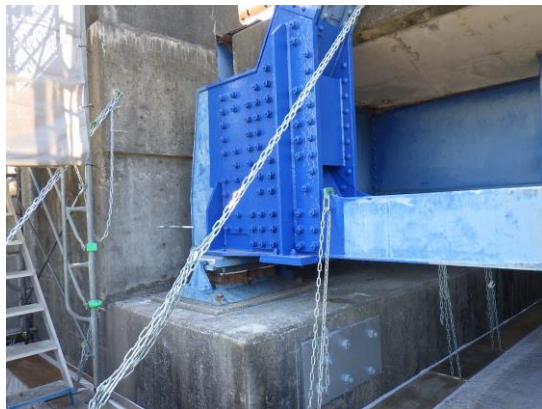
写真 6-28 支承取り替え前
