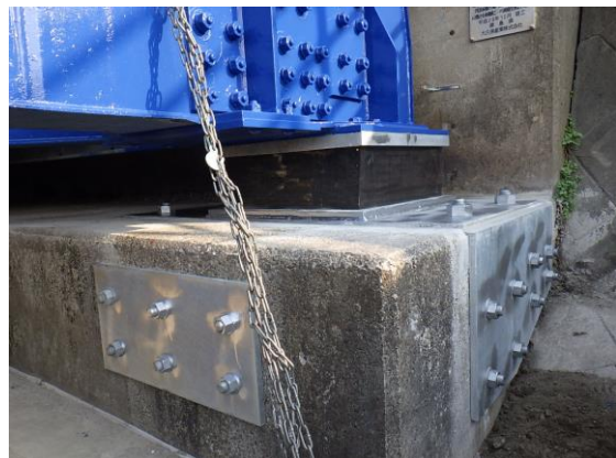
写真 6-27 ゴム支承に取り替え
