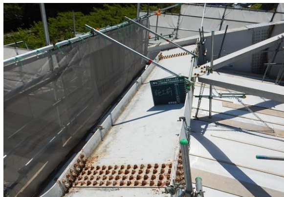
写真 6-21 再塗装前の状況
