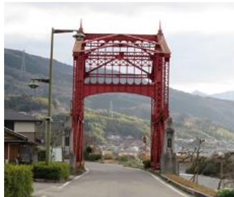
写真 8-3 5 旧穴吹橋の一部を利用
