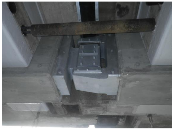
写真6-17 ヒンジ部補修後
