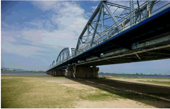
写真 6 - 5 吉野川橋の歩道添加と橋梁下面の状況
