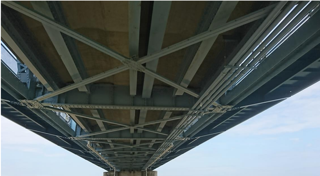
写真 6 - 6 吉野川橋の打ち替え床版及び縦桁の状況
