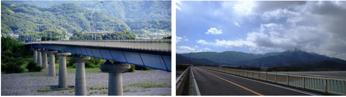
写真8-23 瀬詰大橋（徳島県橋の博物館とくしまHPより）
