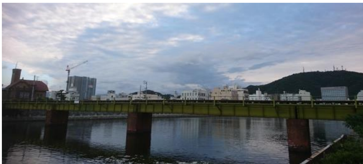
写真 4-16 新町川 JR 鉄橋
