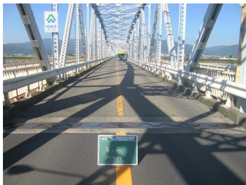
写真 6 - 8 舗装補修着工前
