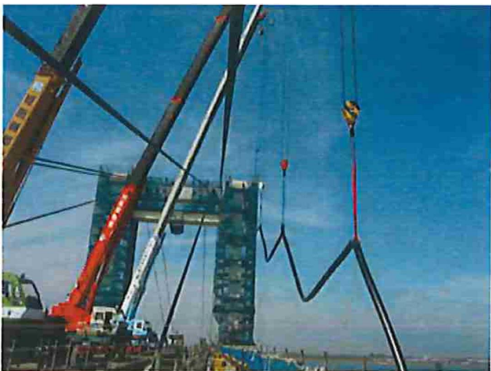
写真5-16 ケーブル架設 クレーン相吊
