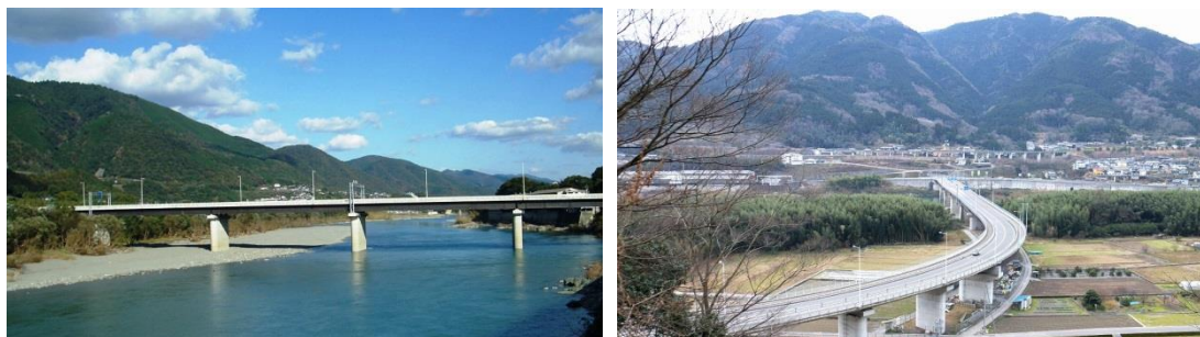
写真 8-46 四国中央橋 (徳島県橋の博物館とくしま HP より)
