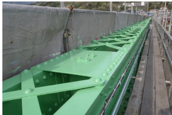
写真 6 - 4 補剛桁再塗装後
