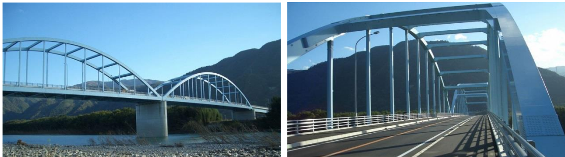
写真 8-42 角の浦大橋 (徳島県橋の博物館とくしま HP より)
