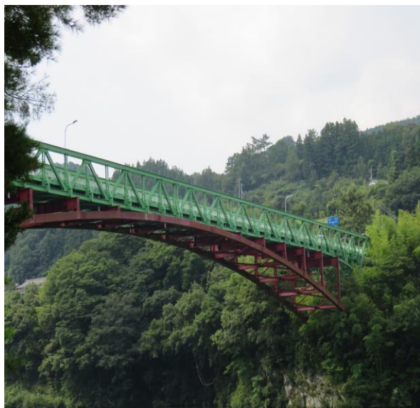
写真 6-5 リニューアルした三好橋
