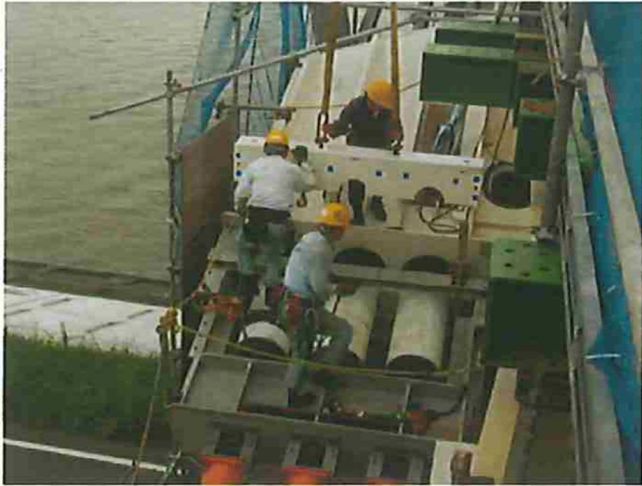
写真5-17 斜ケーブル定着 1000 t ジャッキ
