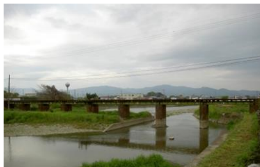
写真 4-15 飯尾川 JR 鉄橋
