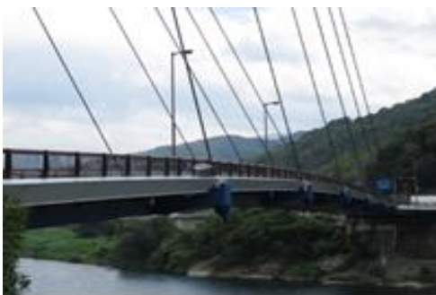
写真8-26 岩津橋側面（フェアリング）
