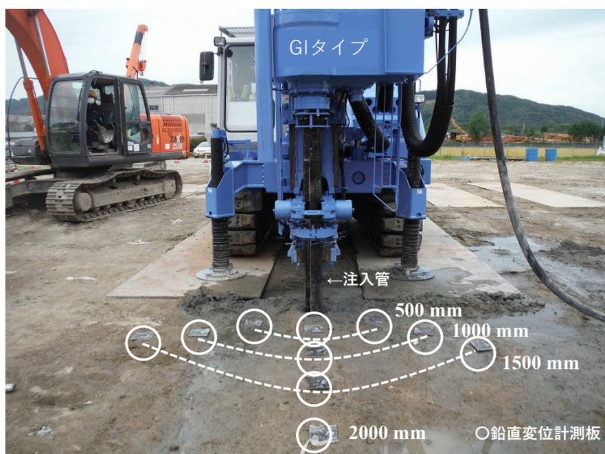
図-5.7 鉛直変位計測板
