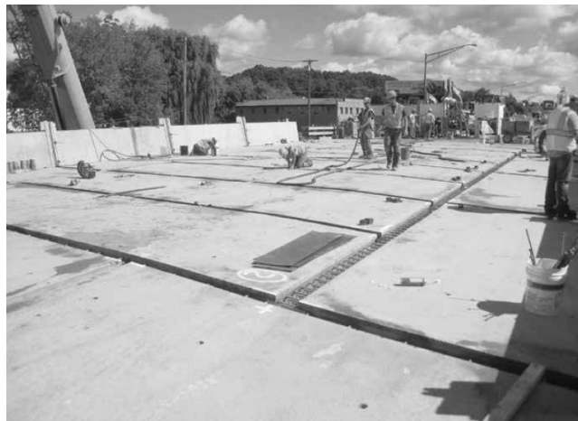
写真-2.3 UHPC を採用した床版間接合の海外での施工例[40]
