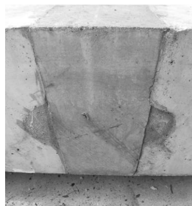
(ii) 接合部側面の状況
