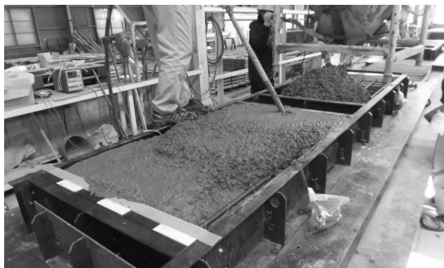
(i) コンクリートの打込み
