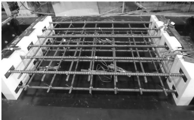
(ii) 先端治具と周囲の緩衝材の設置完了
