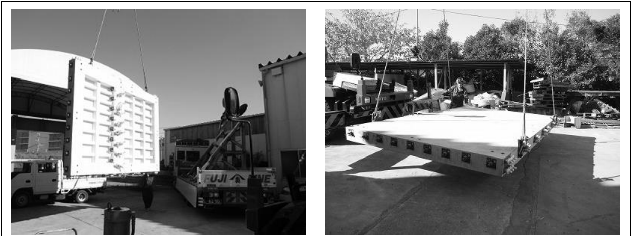
UFC 床版の搬入・設置
