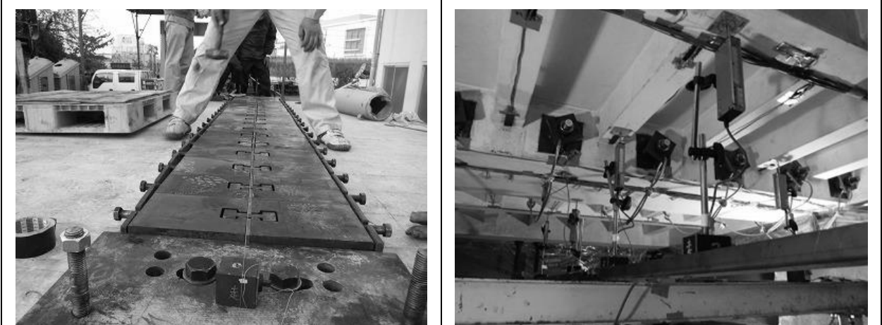
載荷ブロック設置
