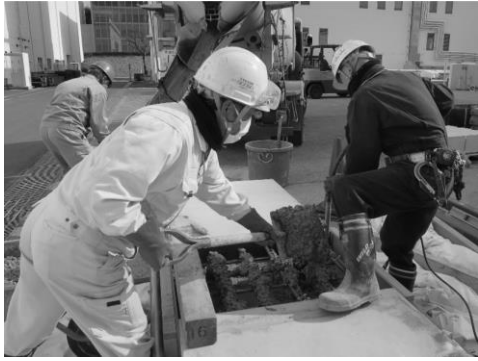
間詰コンクリート打込み
