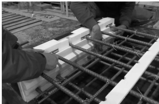
(iii) せん断キ一部分の箱抜き枠設置
