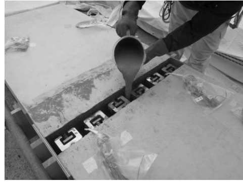
間詰モルタル打込み
