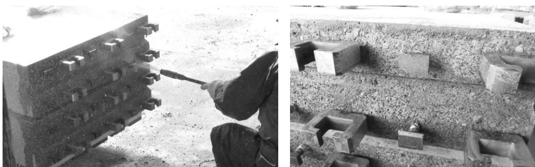
(iii) レイタンス処理（接合面）状況
