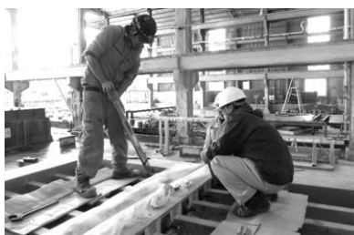
写真-3.1 トルクレンチでの PC 鋼棒の緊張状況
