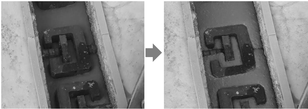
写真-5.8 間詰め材の充填状況
