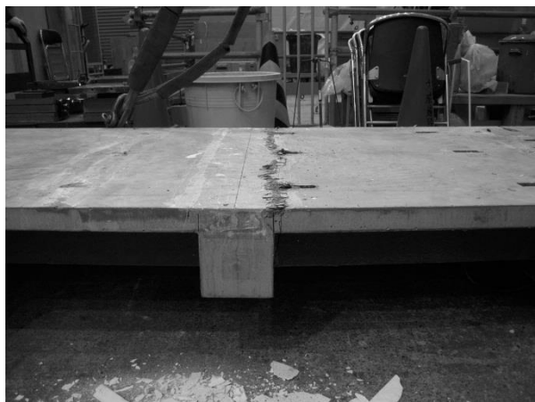
載荷位置のひび割れ（実験終了後）
