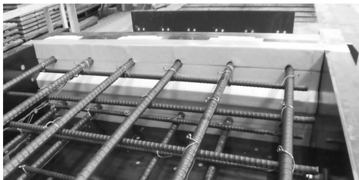
(iv) 接合面（先端治具付近）の型枠組立完了
