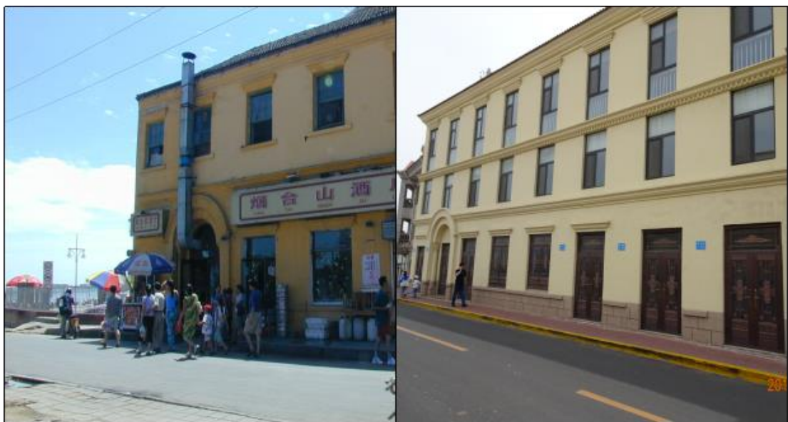
写真 2-3 海岸街建築物修復状況 (左：2002.8 右：2018.5)
