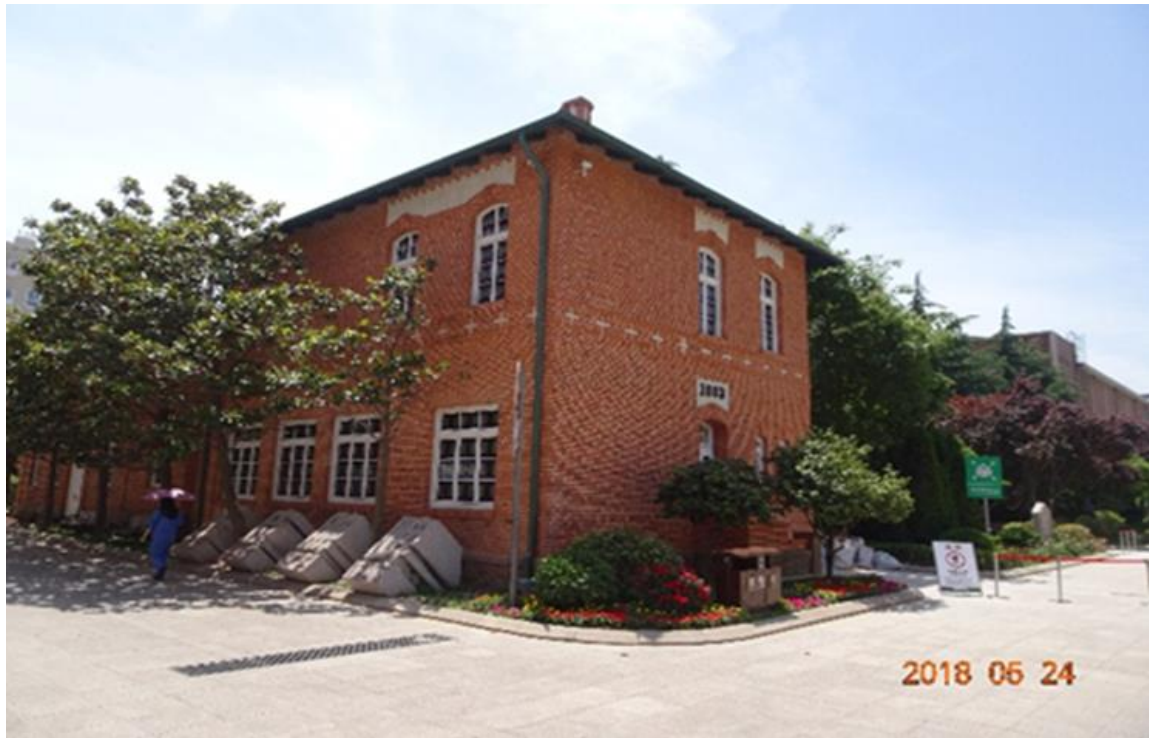
写真 3-1 青島ビール醸造工場内の保護対象建築物
