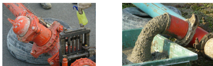
写真 3.3.1 T字管（F2, F3 および F4）による試料採取状況
