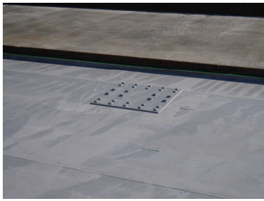
(1) き裂発生箇所の補修
