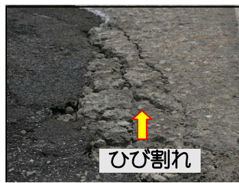
(1) 10mm 程度のひび割れ発生 (2) 5mm 程度のひび割れ発生 写真－2.4 床版の上面損傷
