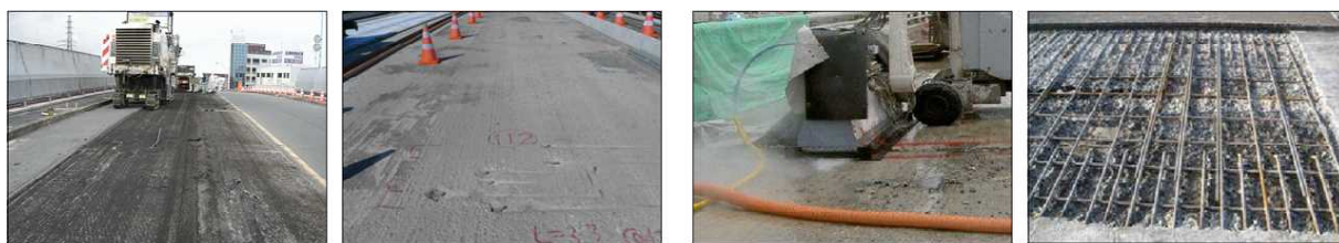
1) 機械による切削 2) 切削表面 1) WJ による削り 2) コンクリート除去 (1) 専用の大型機械による切削 (2) WJ による削り
