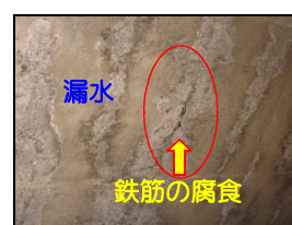
(1) 2方向ひび割れ (2) 2方向ひび割れ (1)鉄筋の露出と漏水 (2)漏水と錆汁の発生 と遊離石灰
