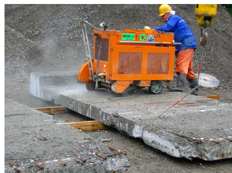
写真－ 5.3 床版供試体の切出し状況
