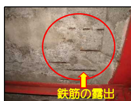
(1) 2方向ひび割れ (2) 2方向ひび割れ (1)鉄筋の露出と漏水 (2)漏水と錆汁の発生 と遊離石灰
