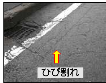
(1) 10mm 程度のひび割れ発生 (2) 5mm 程度のひび割れ発生 写真－2.4 床版の上面損傷
