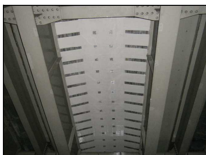
(1) CFS 接着補強法
