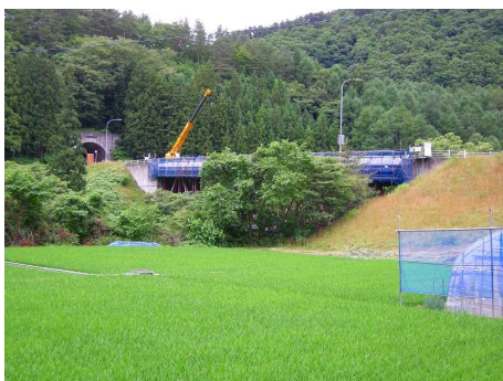
写真－ 5.2 RC 床版撤去橋梁
