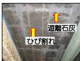
(1) 2方向ひび割れ (2) 2方向ひび割れ (1)鉄筋の露出と漏水 (2)漏水と錆汁の発生 と遊離石灰
