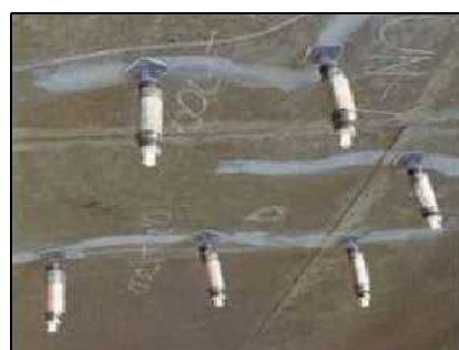
(2) ひび割れ補修
