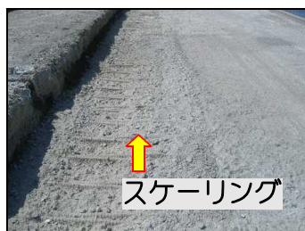
(1) 土砂化 (2) 2方向ひび割れと遊離石灰 写真－ 2.3 積雪寒冷地域の RC 床版の損傷事例
