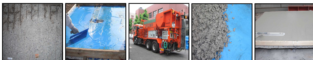
(1) 切削・研掃 (2) 接着剤塗布 (3) SFRC 練り混ぜ (4) SFRC 打ち込み (5) 表面仕上げ 写真－ 5.9 補強手順
