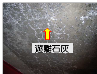
(1) 土砂化 (2) 2方向ひび割れと遊離石灰 写真－ 2.3 積雪寒冷地域の RC 床版の損傷事例
