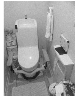
写真 7-11 高さ変更可の両側の手すり例
