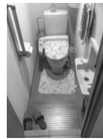
トイレは使用しない。廊下より200mm下がっている。踏み台を設置し段差を2段に分割している
