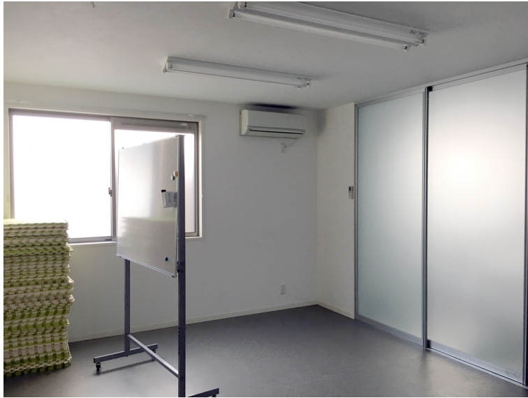
写真 5-3 可動間仕切り（B施設）
