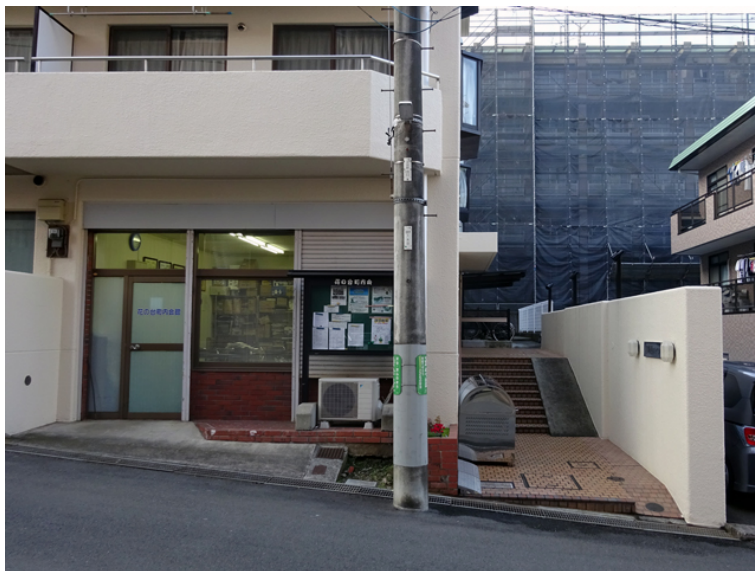
写真 6-2 前面道路から段差なく直接出入りできる（D施設）
