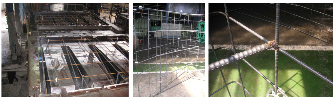
(a)L型擁壁打設面
