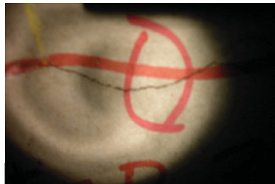
図5.7 シールドトンネルでのひび割れ発生状況
