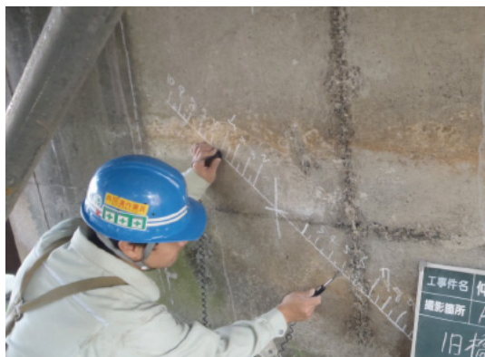
写真5.9 同一面配置法による測定状況写真 5.12)
