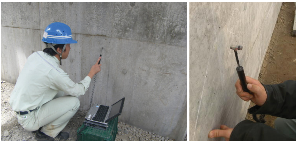
写真4.3 実構造物での接触時間の測定状況
