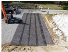
(a) 補強材敷設
