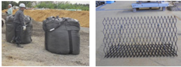
(a) 耐候性大型土のう及び壁面材
