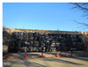
(d) 上載盛土構築・応急復旧盛土完成
