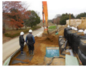
(f) 裏込め材敷均し
