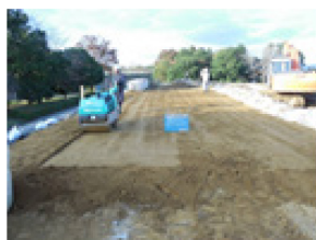
(d) 上載盛土構築・応急復旧盛土完成
