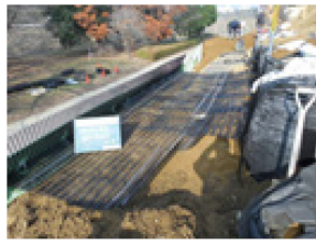
(e) 壁面材及び補強材設置
