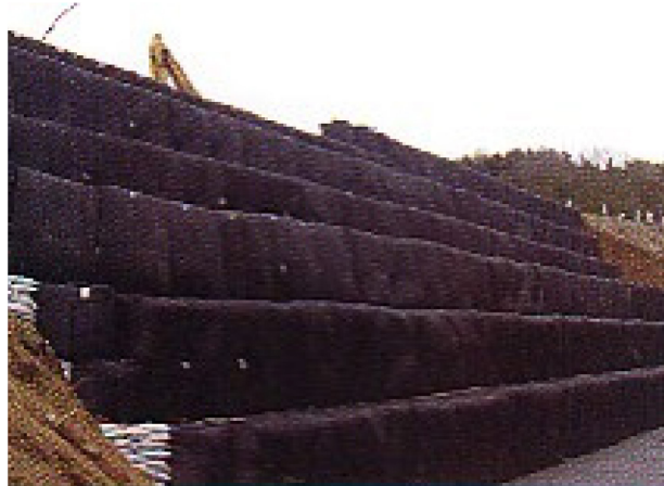
写真-3.2.1 耐候性大型土のうによる復旧状況
