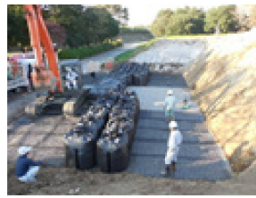
(b) 大型土のう設置
