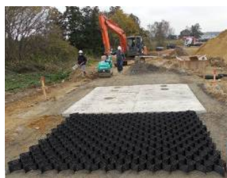
(a) 格子状補強材の設置
