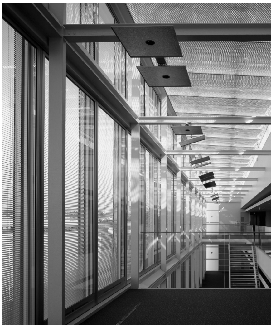
写真 5.2-6 コンパクトダブルスクリーン（壁面）と ETFE フィルムのトップライト
