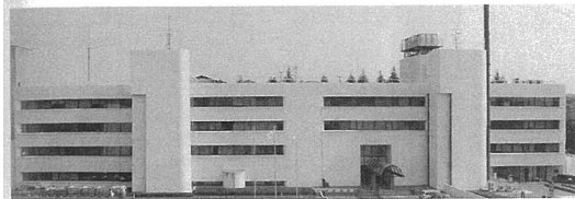
リニューアル前の外観（1979年竣工）
