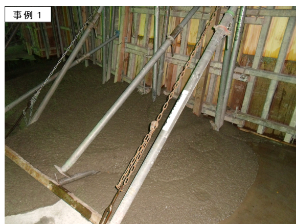
写真1.3.1 コンクリートの側圧が過大となり型枠からコンクリートが漏出（パンク）した事故
