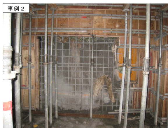
写真1.3.1 コンクリートの側圧が過大となり型枠からコンクリートが漏出（パンク）した事故
