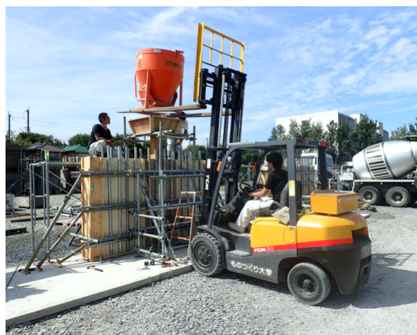
写真 6. 2. 2 コンクリートの打込み状況
