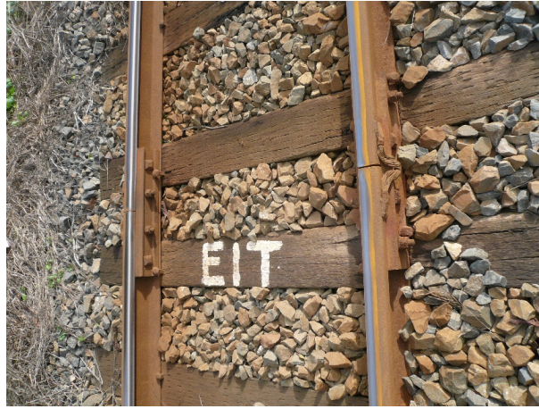
図 4.5.7: 碎石が十分に確認される継ぎ目区間
