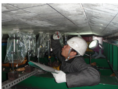
写真-3.2.5 ひび割れ観察状況
