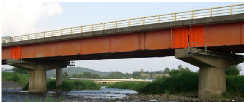
写真-6.3.1 対象橋梁
