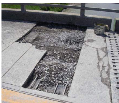
図-1.1.2 床版上面の砂利化 9)
