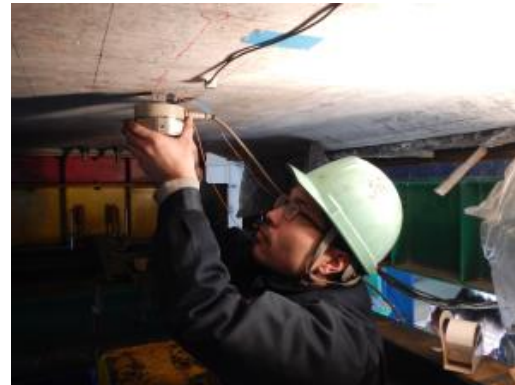
写真-6.4.1 測定状況
