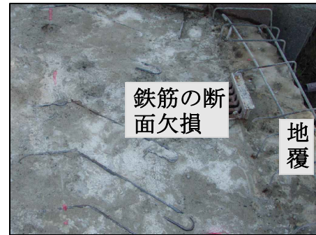
(2) 斜橋の張出部の損傷
