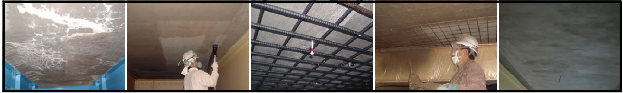
(1) 損傷状況 (2) 下地処理 (3) 補強鉄筋配置 (4) モルタル吹付け (5) 完成 写真－ 2.13 下面増厚補強法の施工事例 2,29)
