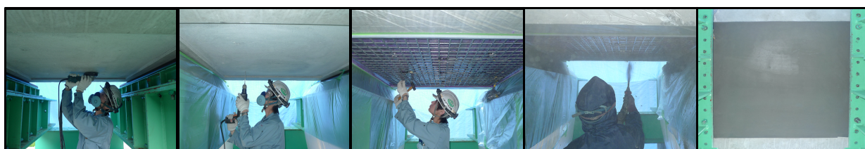
(1) 表面処理 (2) アンカー穴穿孔 (3) 引張補強材設置 (4) PCM 吹付け (5) 表面仕上 写真－ 6.2 プライマー R 塗布型 PCM 下面増厚補強
