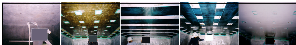
(1) 下地処理 (2) プライマー (3) 1 層目接着 (4) 2 層目接着 (5) 表面保護 塗布
