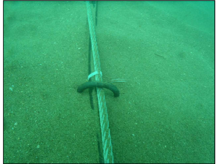
沖波高計ケーブル配線固定状況
