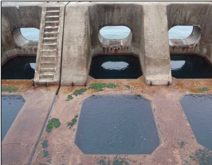
消波護岸・設置マス
