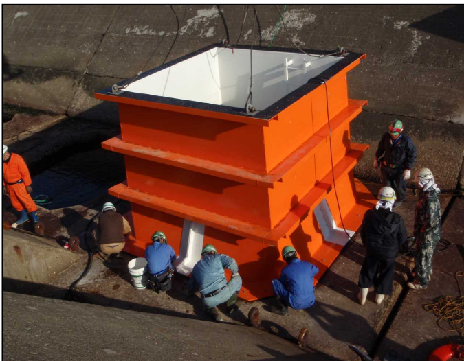
基部・下部空気室設置状況
