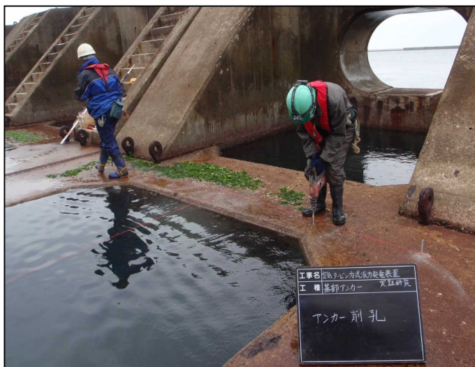
アンカー削孔状況
