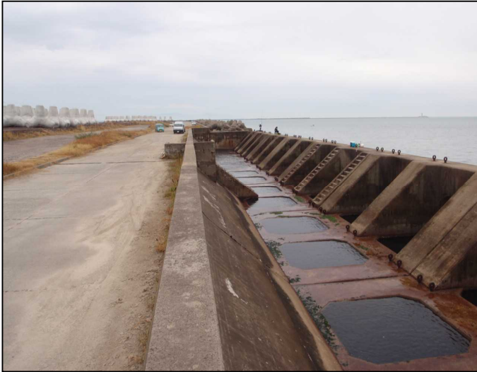
酒田港高砂地先 消波護岸・北側より
