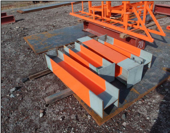
機械室・電気室サポート
