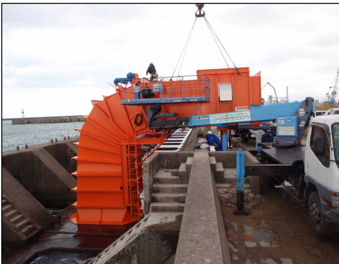
機械室設置ボルト固定状況
