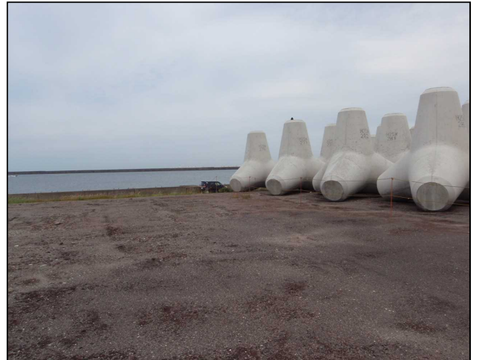
使用陸上ヤード(酒田港湾事務所ブロック製作ヤード)
