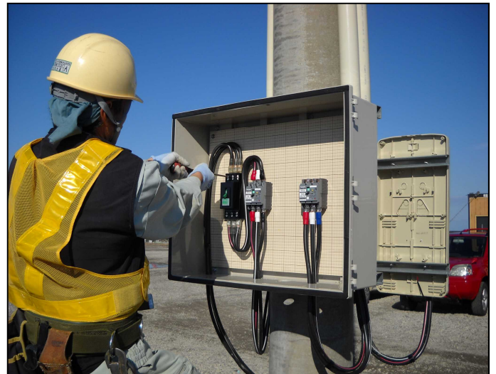
分電盤取付状況
