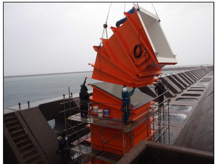
中間部・上部空気室設置状況
