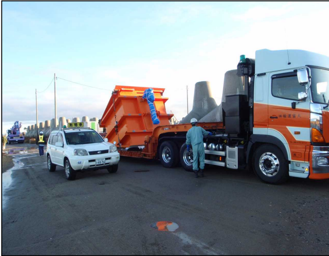
上部空気室搬入状況
