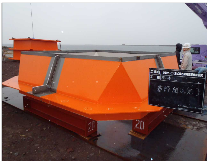
基部組立完了
