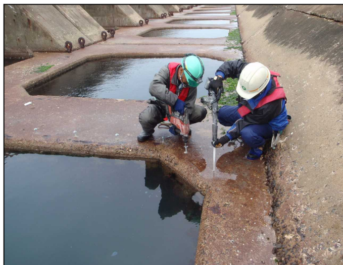
ケミカル注入、アンカー取付状況
