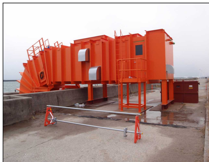
機械室・電気室設置完了
