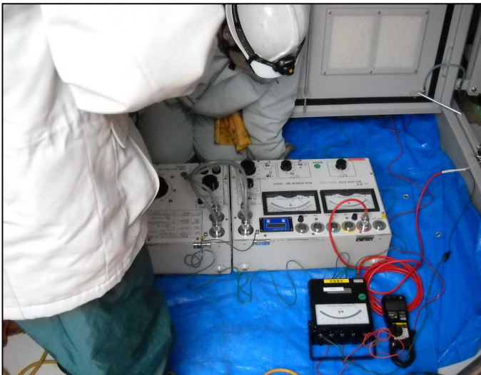
電気室制御盤配線確認状況
