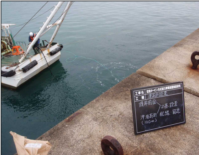
護岸前面波高計設置状況
