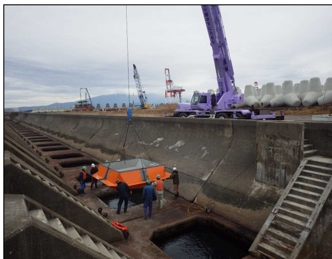
基部仮設置、アンカー位置確認
