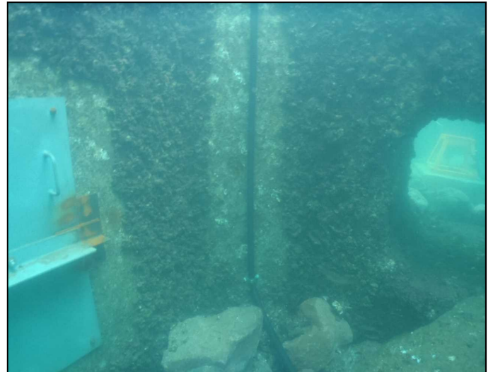
護岸内壁面ケーブル配線固定状況
