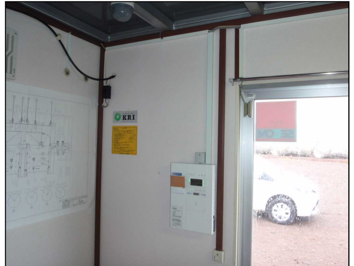
計測室防犯対策・セコム設置
