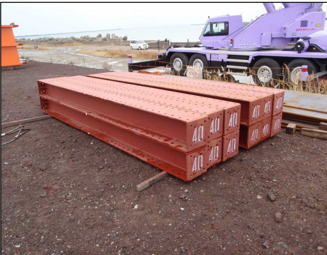
発電装置組立架台(山留材)
