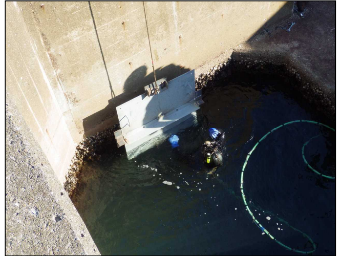
止水蓋取付状況
