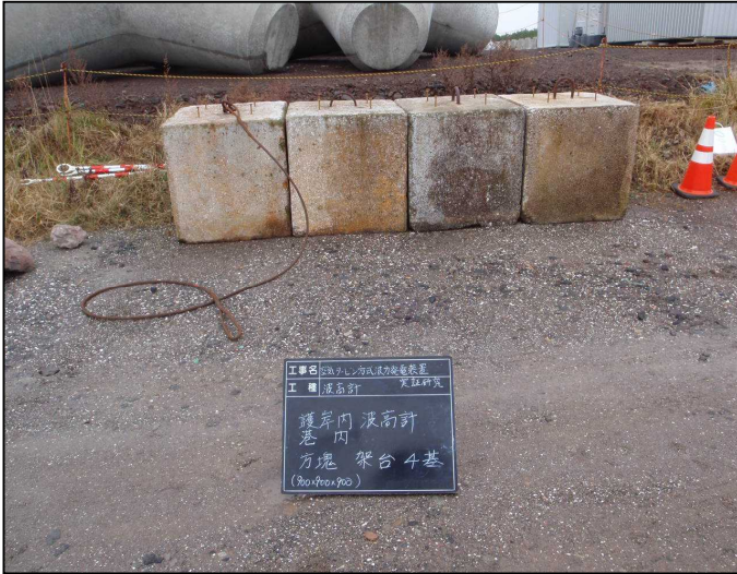
波高計方塊架台(方塊0.9*0.9*0.9m)
