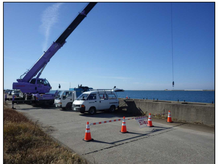
ラフテーンクレーンによる止水蓋吊り降ろし
