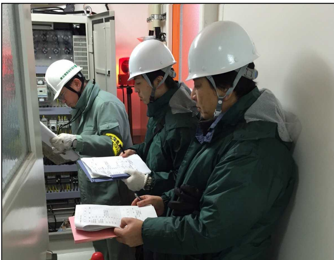
経産省検査状況(電気室内)
