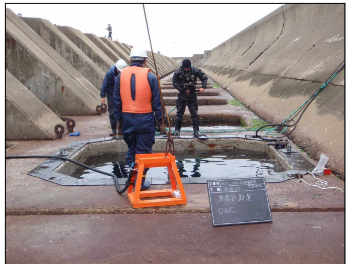
OWC波高計設置狀況
