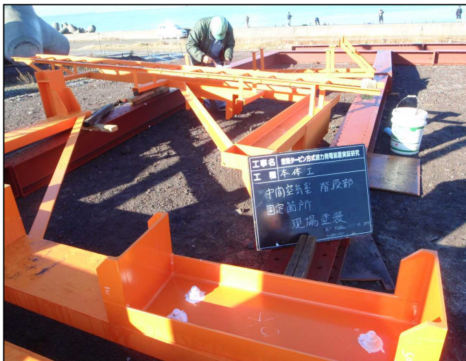
架設架構固定箇所塗装状況
