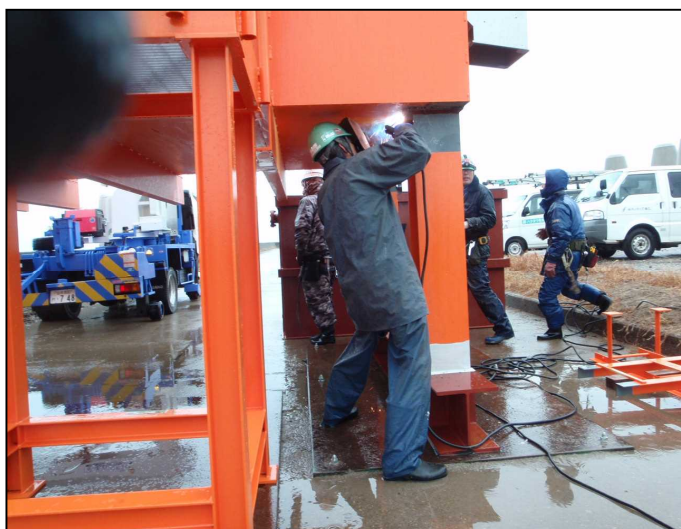
サポート溶接状況
