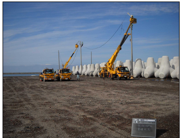
架線取付状況
