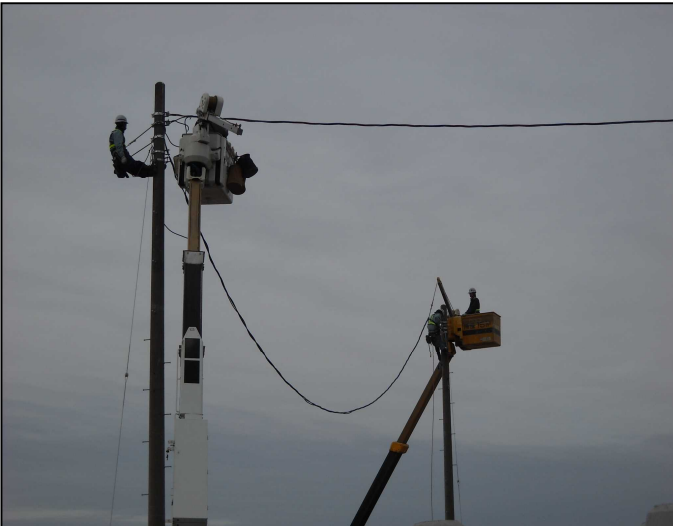
架線取付状況
