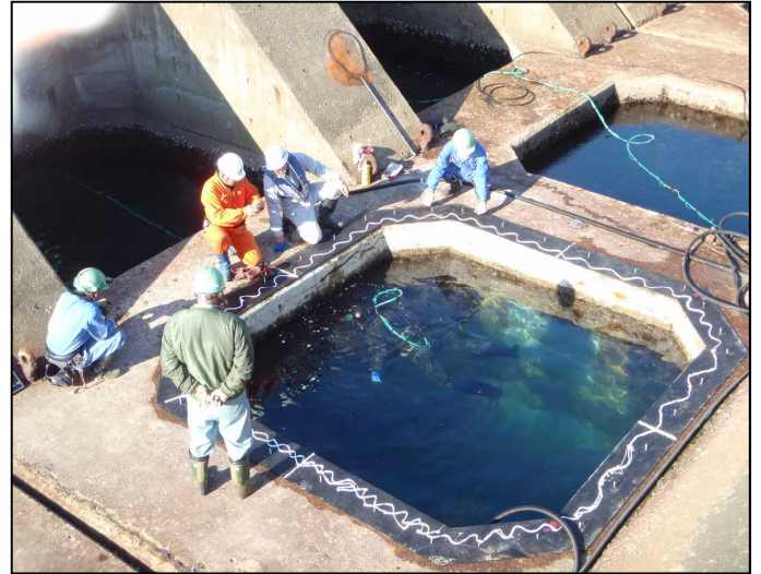
ゴムパッキンコーキング材塗布状況
