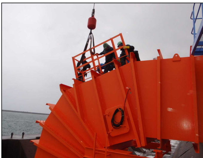
パワーシリンダ・メンテナンスデッキ組立
