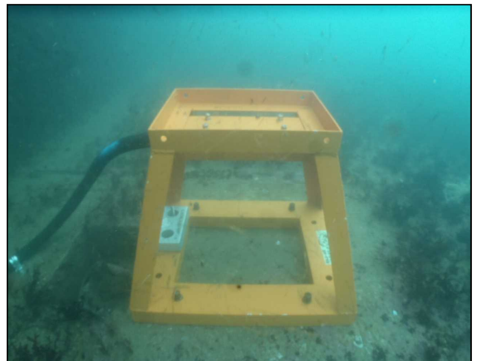
護岸前面波高計設置完了
