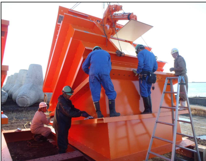
中間部・上部空気室接続、塗装状況
