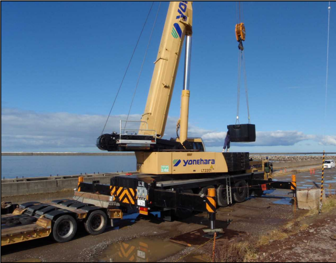
オールテレーンクレーン(220t吊)搬入組立状況
