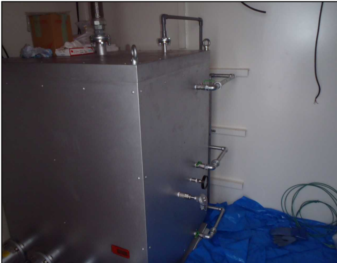
配管取付完了
