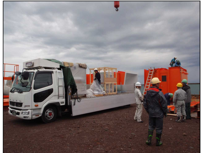
電気制御盤・温水器搬入状況
