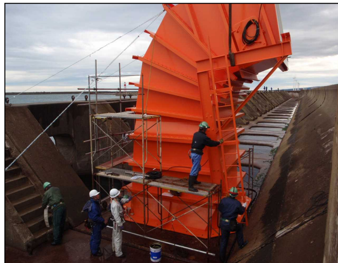
架設架構設置状況
