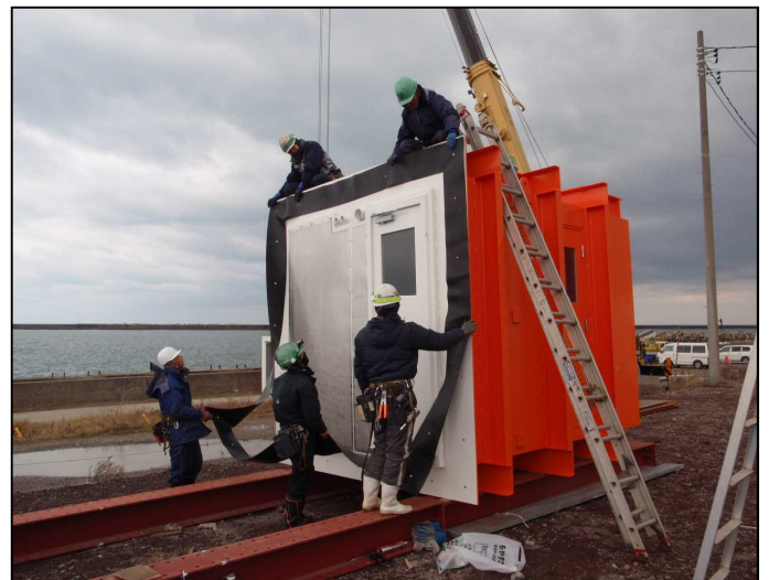
電気室接続部ゴムパッキン取付状況
