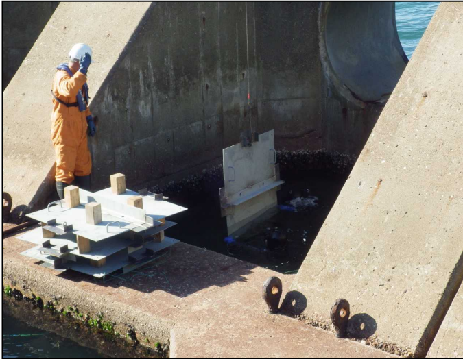
止水蓋取付状況
