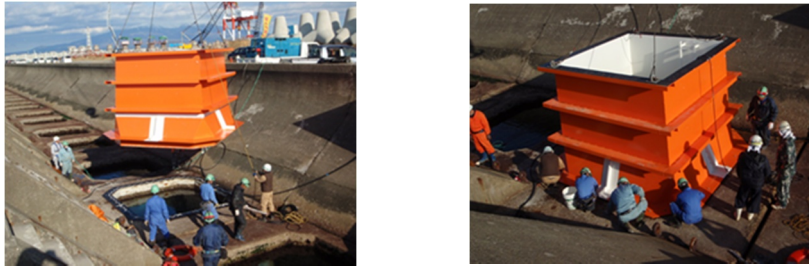
写真 8.3 最下部ブロック施工状況
