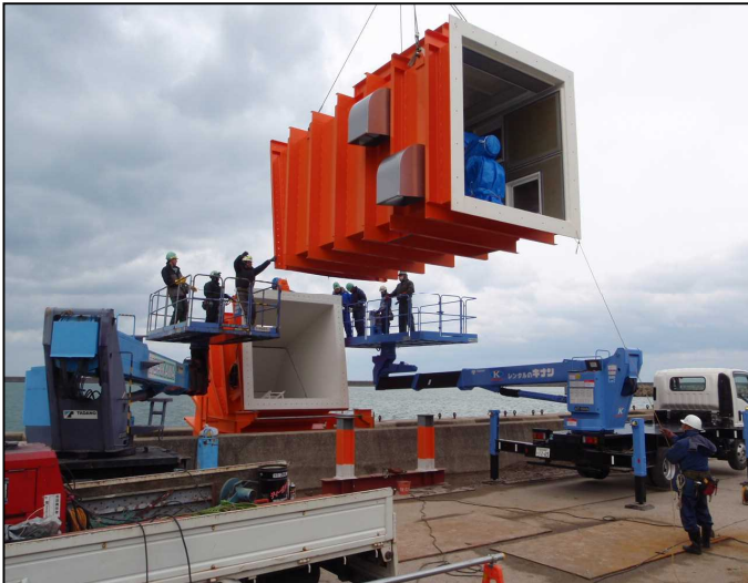
機械室設置状況
