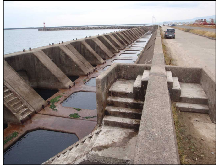
消波護岸・南側より
