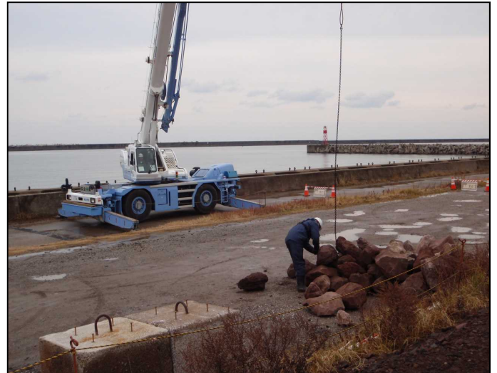
間詰石設置狀況
