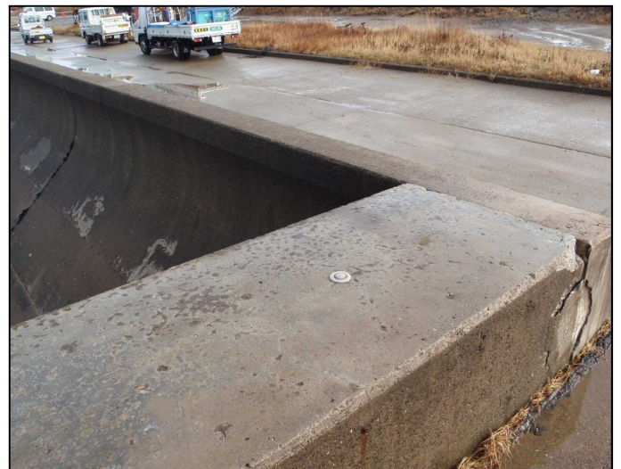
基準点：消波護岸南側端部 護岸天端(標高CDL+4.780m)
