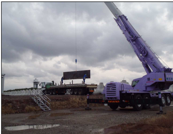
敷鉄板搬出状況
