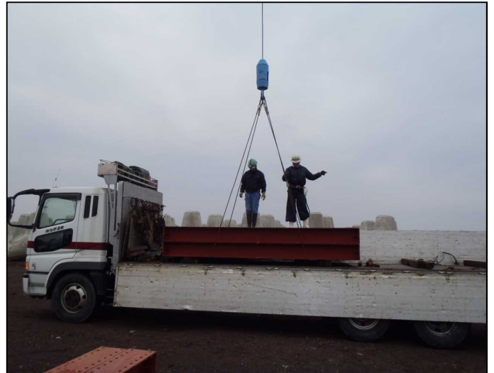
発電装置組立架台搬入状況
