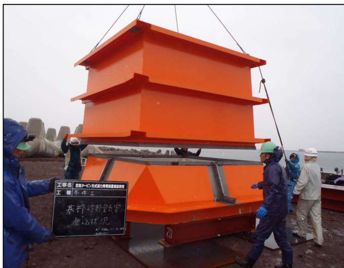
基部・下部空気室接続状況
