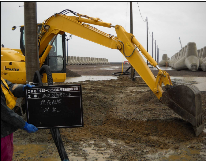
埋設配管埋戻し状況
