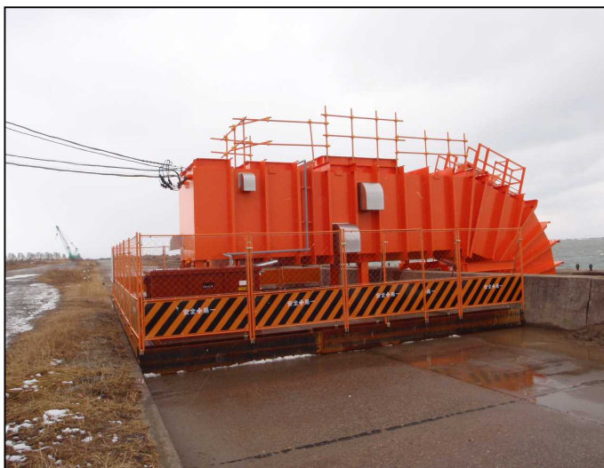
外周フェンス設置完了
