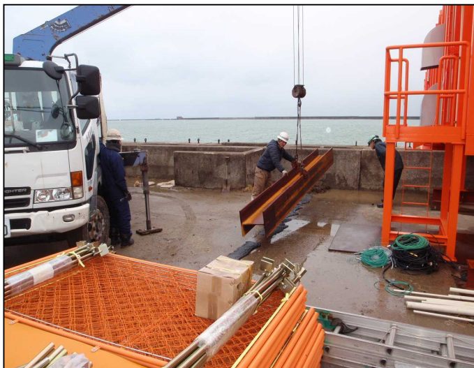
外周フェンス基礎(H形鋼)設置状況
