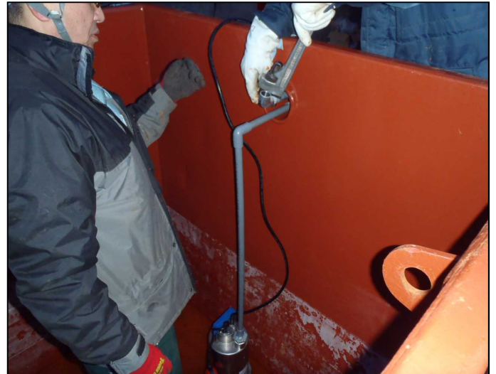
水槽内水中ポンプ取付状況
