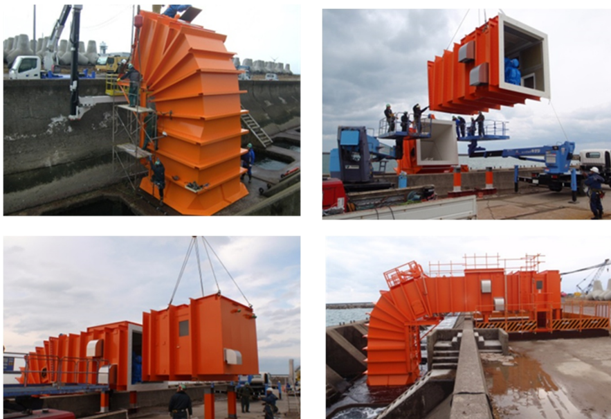
写真 8.4 ブロック架設状況
