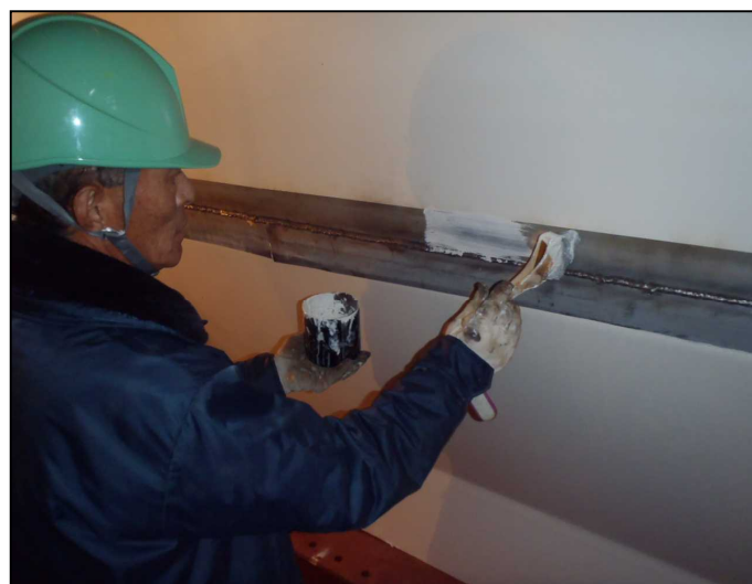
全周溶接箇所塗装状況
