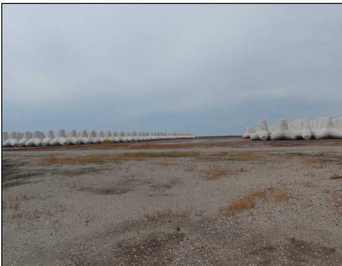
使用陸上ヤード(酒田港湾事務所ブロック製作ヤード)
