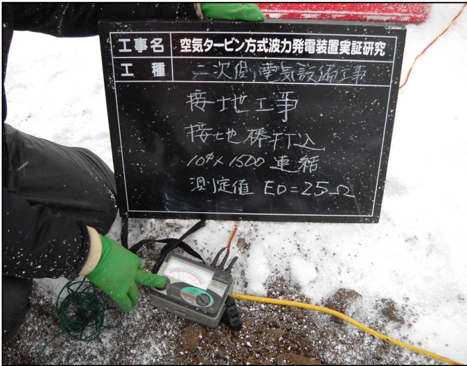
接地棒打込、確認状況
