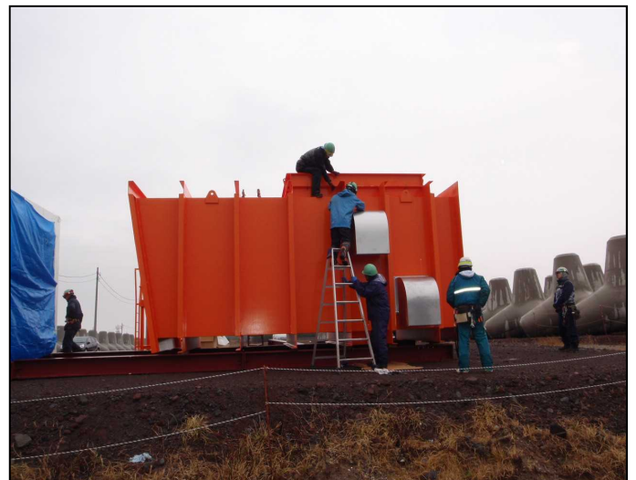
屋外フード取付状況
