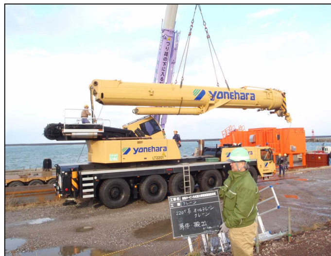
オールトレーンクレーン(220t吊)解体搬出状況
