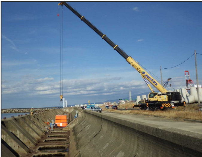
基部・下部空気室設置状況
