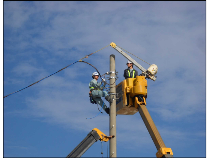
架線取付状況
