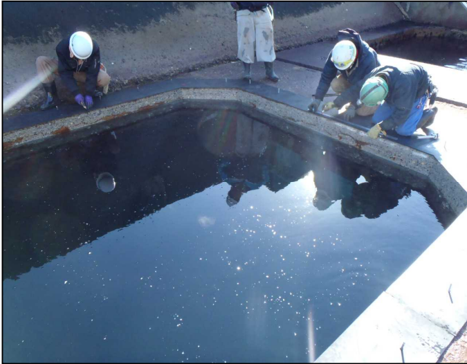
基部取付部ゴムパッキン取付状況
