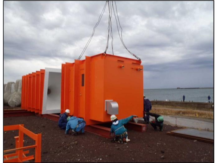
電気室荷卸状況
