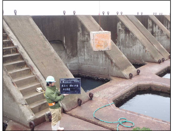
波高計方塊架台設置狀況
