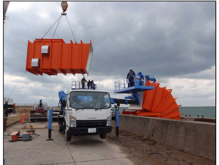
機械室設置状況
