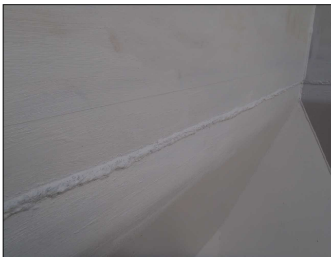
全周溶接完了
