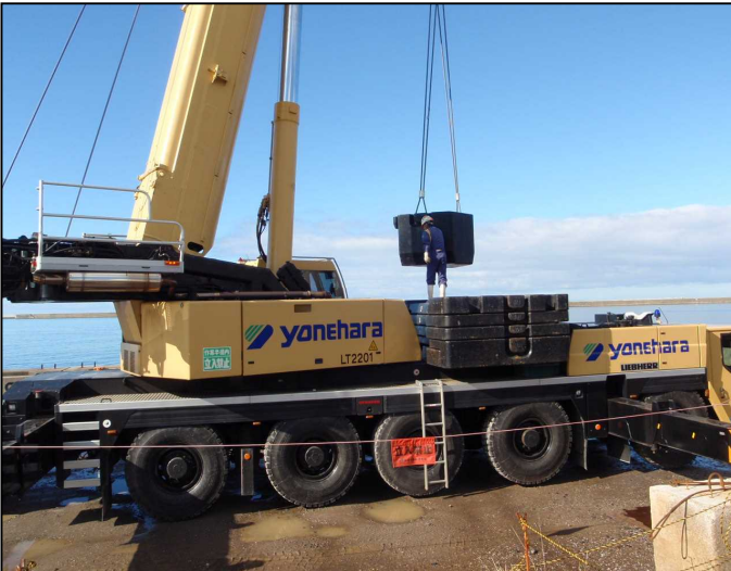
オールテレーンクレーン搬入組立状況
