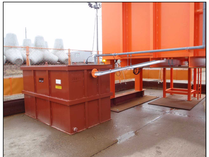
温水器・水槽設置完了
