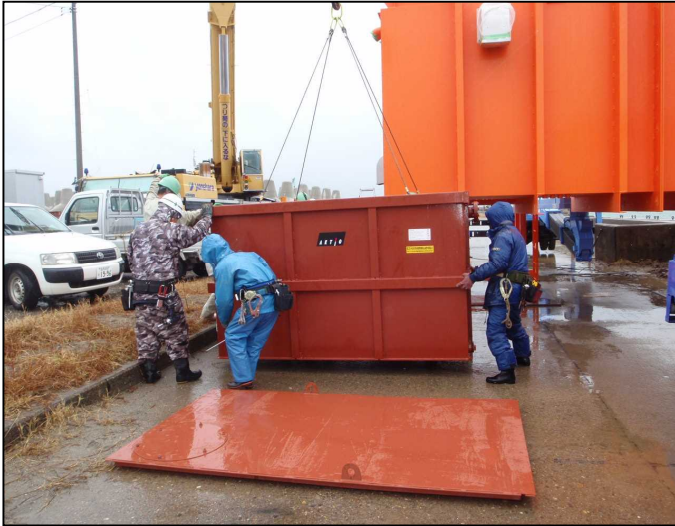
水槽(5m 3 )設置状況
