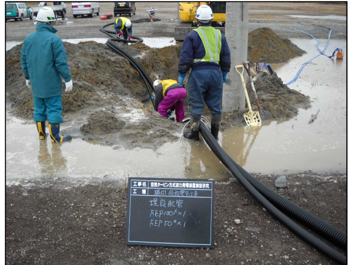
埋設配管 (FEP100φ、FEP50φ)
