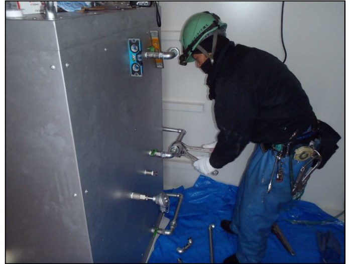
配管取付状況
