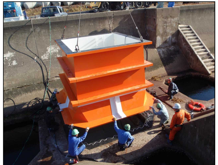
基部・下部空気室設置状況
