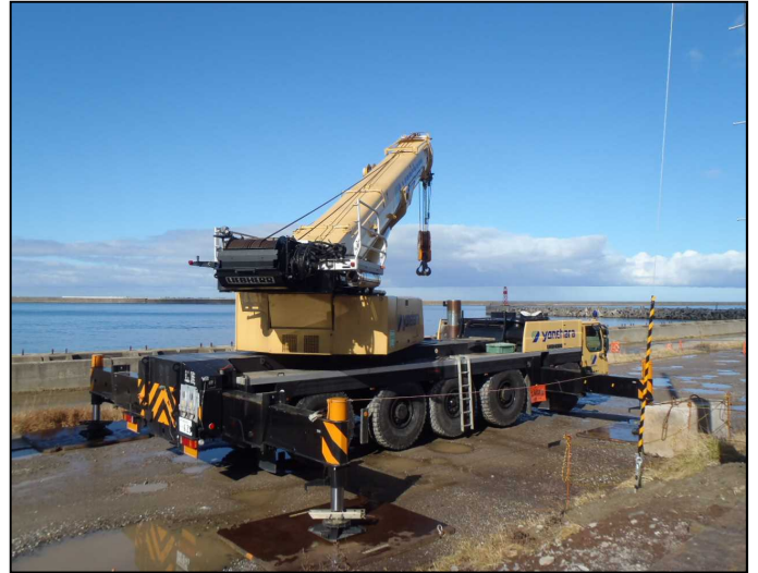
オールテレーンクレーン搬入組立状況
