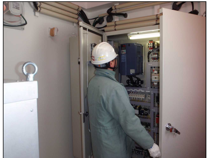
電気保安協会定期点検状況
