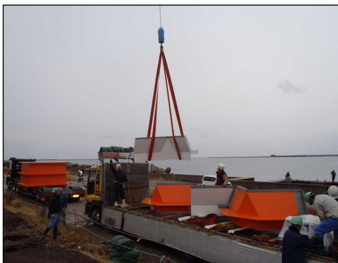
基部・下部空気室搬入状況
