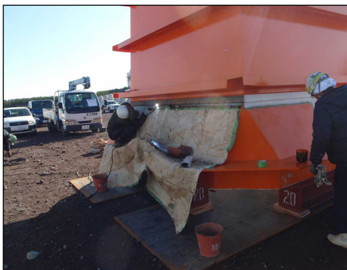
基部・下部現場全周溶接状況(外側)
