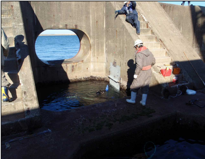
止水蓋取付状況
