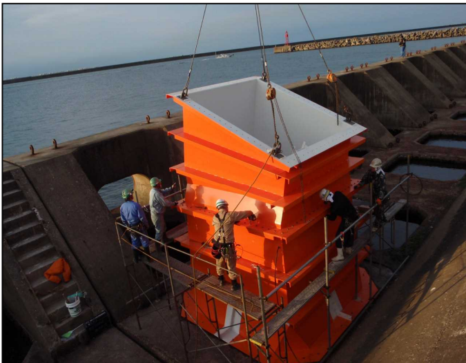
中間下部空気室設置状況
