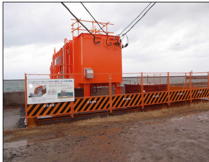
外周フェンス設置完了
