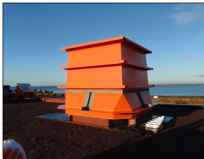
基部・下部空気室接続完了
