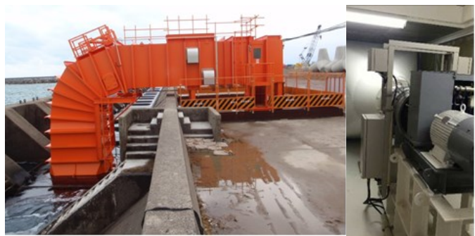
写真 1 PW-OWC 型波力発電装置 (実証実験機)
