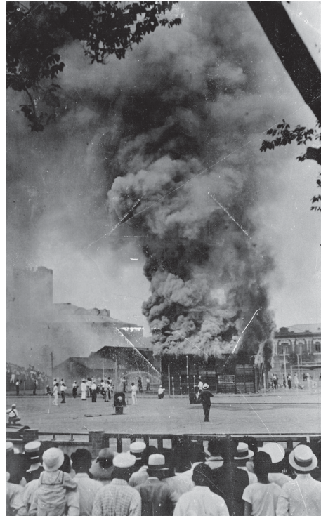
図 1-51 木造家屋火災実験
