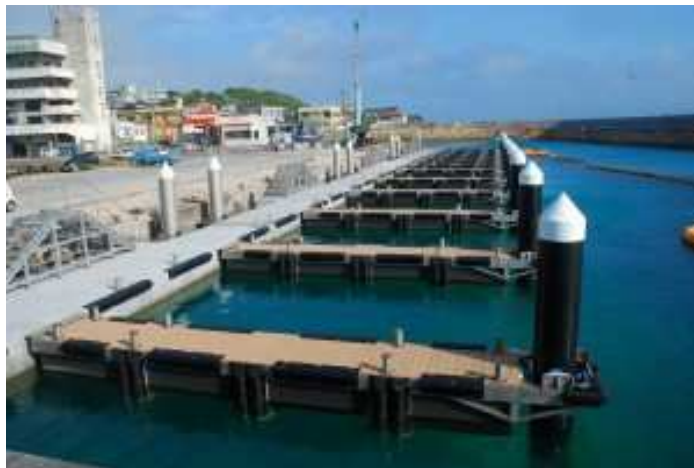
図 5.1 単杭式係留を用いた浮栈橋 18)
