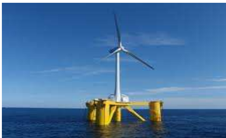
図 5.4 チェーンカタナリー係留を用いた洋上風力発電 21)
