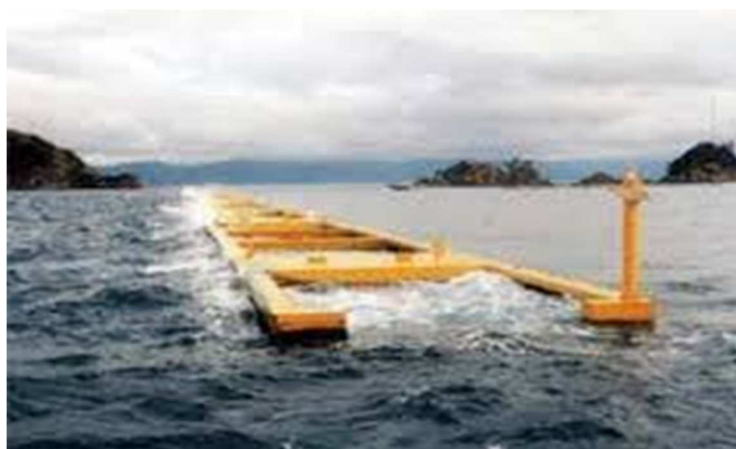
図 5.5 チェーンカタナリー係留を用いた浮消波堤 22)
