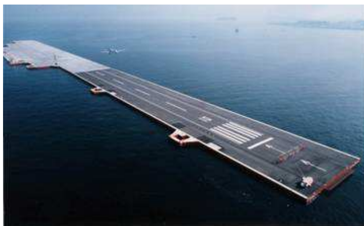
図 5.2 ドルフィン式係留を用いたメガフロートの実験浮体 19)
