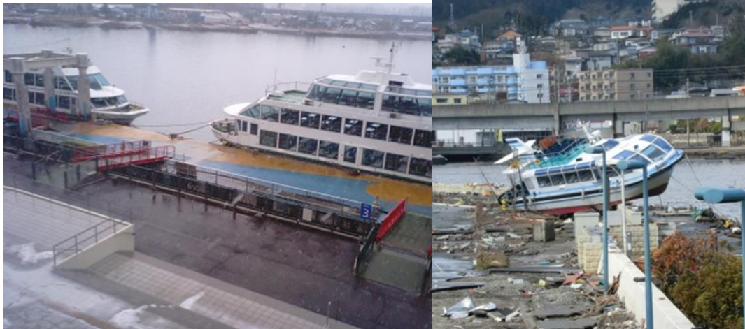
図-4.2.1 マリングート塩釜の浮棧橋への係留状況と固定式護岸での被災状況
