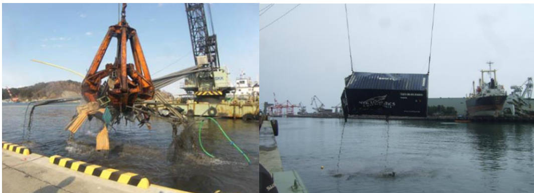
図－2.1.3 航路啓開の状況 3) （宮古港<左>、仙台塩釜港<右>）
