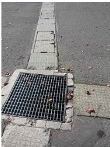
側溝破損
