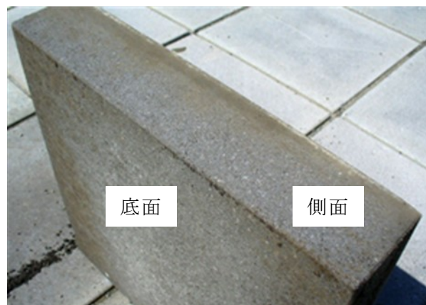
写真-4.2.2 補修に伴って取り外した石板の側面及び底面
