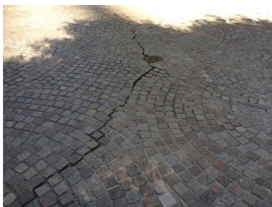
写真-2.3.1 既往の天然石舗装の破損状況（東京駅付近）
