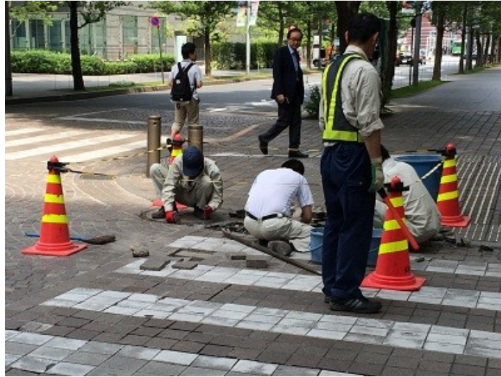
写真-2.3.2 既往の天然石舗装の補修状況
