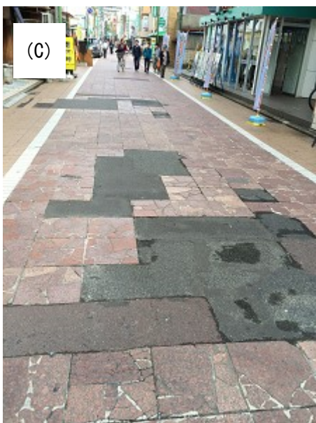
写真-2.3.3 ブロック系舗装の補修状況
